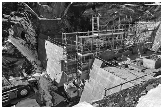
急傾斜地での工事
