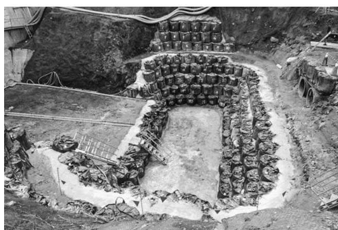
崩落後の土留め状況
