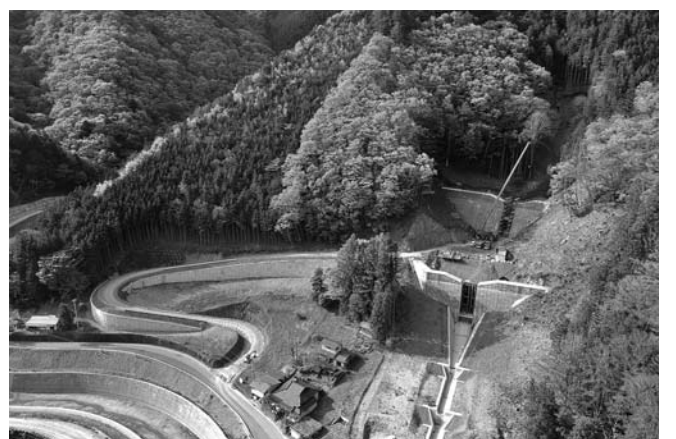
不透過型重力式コンクリート砂防堰堤
