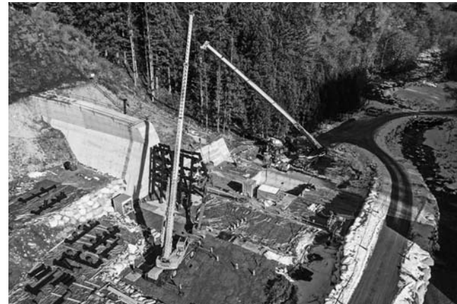
施工風景(上流側から)
