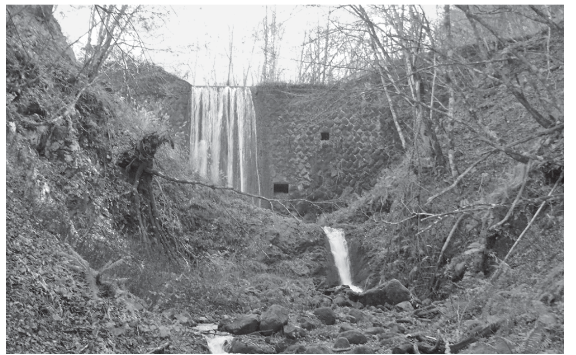
岩坪谷第一号砂防堰堤(岐阜県高山市)
