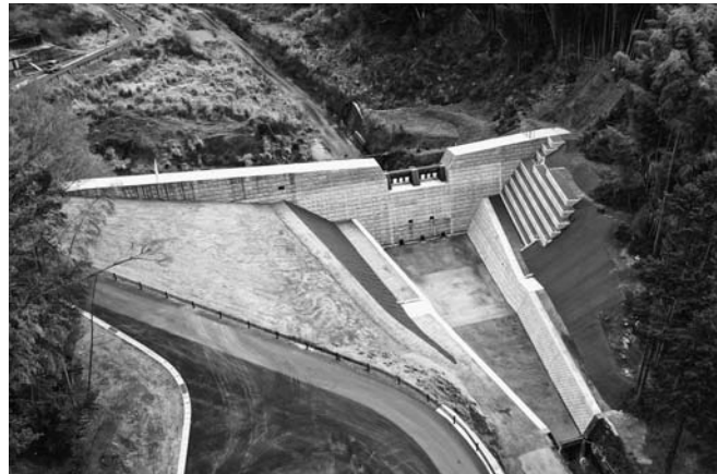
完成した第3砂防堰堤
