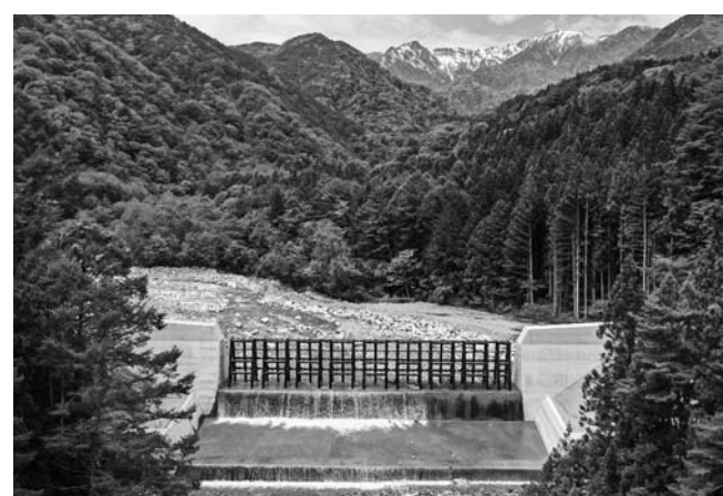
完成写真(下流側から)
