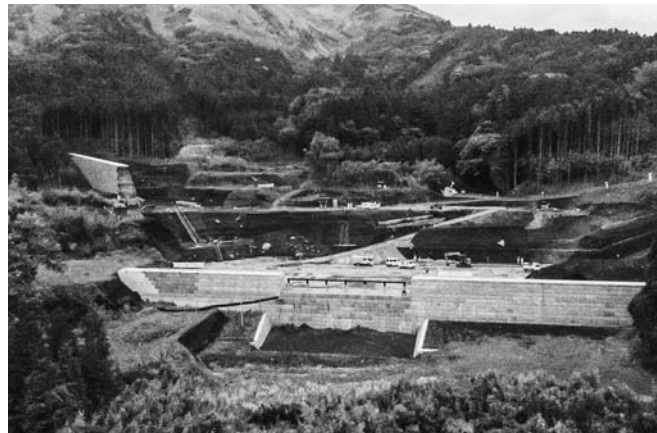
砂防堰堤の施工状況
