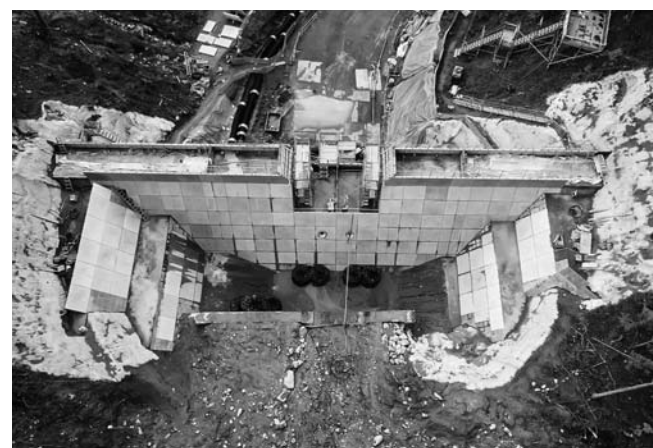
大型土のう裏込め材で地盤保護
