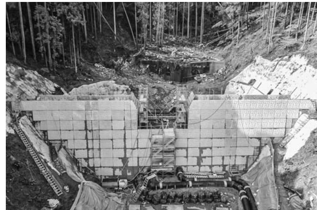
施工中の砂防堰堤本体工
