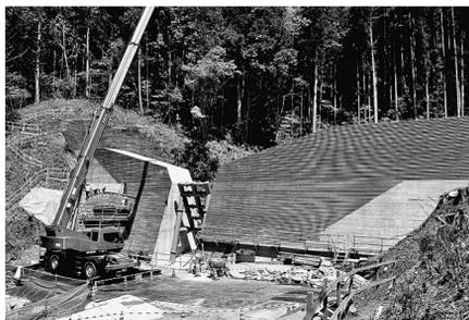
コンクリート打設が完了した堤体(2023年5月)
