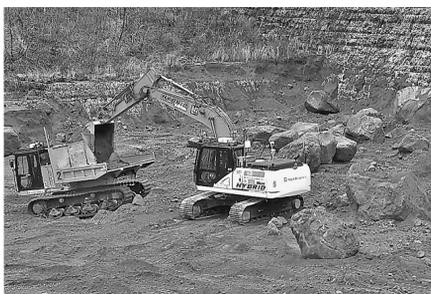
遠隔操作式重機による土砂の掘削・運搬
