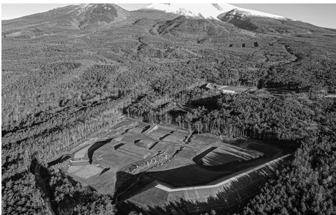
浅間山を背景にした現場全景
