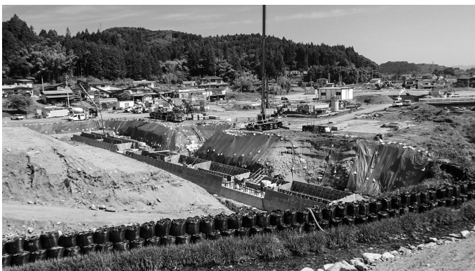
主堰堤は躯体構築が本格化
