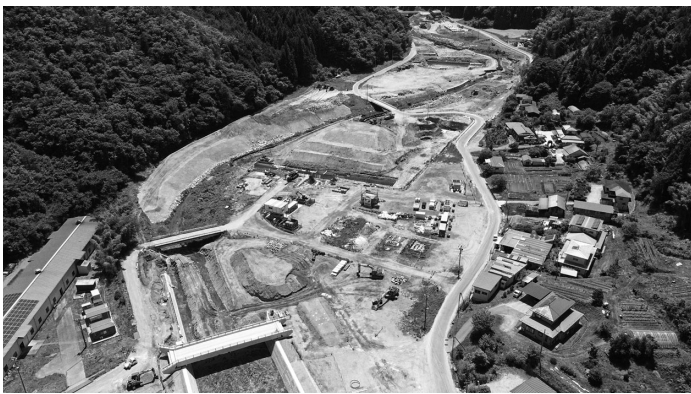
工事現場の全景
