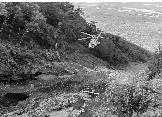
大沢崩れでのコンクリート打設状況
