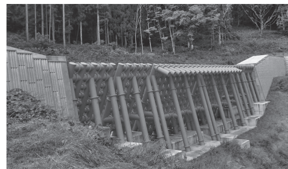
鋼製砂防堰堤〔長野県小谷村ガン沢〕(長野県小谷村HPより)
