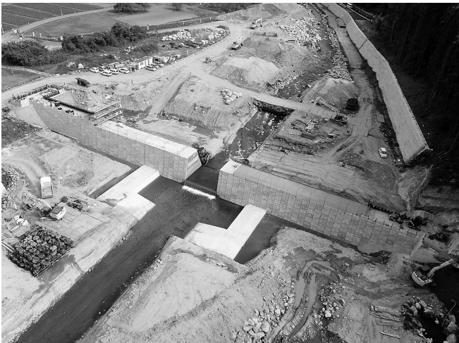
コンクリート堰堤施工状況(下流側からの全景)
