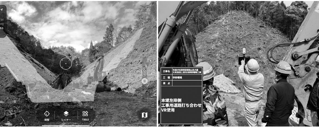
AR(拡張現実)を用いた現地での重機走路検討
