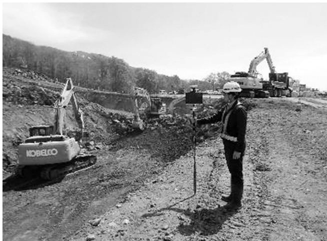
本堤掘削 AR活用
