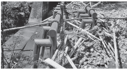
向山堰堤の張出しタイプ流木捕捉工 〔和歌山県有田川町沼谷川〕(提供：日鉄建材㈱)
