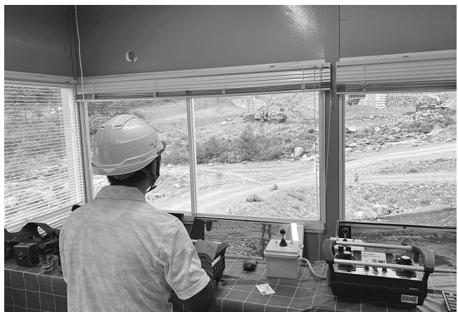
200m離れた場所で建機を操作するオペレーター
