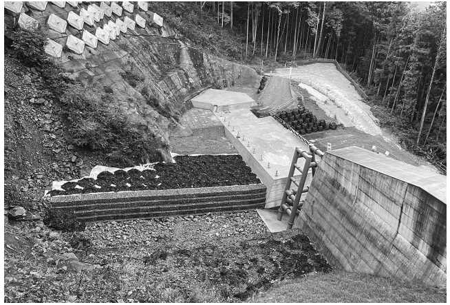
堰堤の裏込めも施工する
