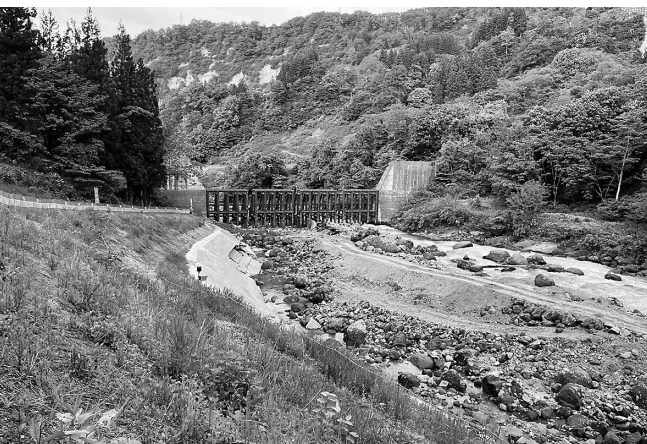
上流側から見た全景
