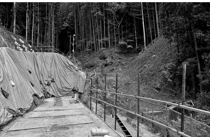
掘削工事を控えた堰堤設置場所
