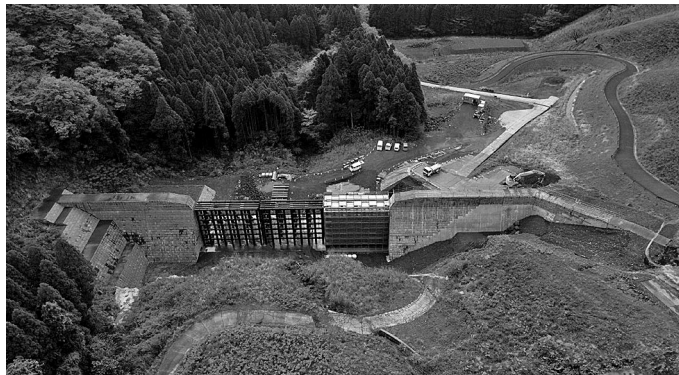
上流側からの施工状況
