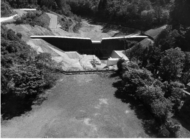
堰堤整備が進む現場周辺
