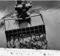
カルシア混合バケットでの施工状況
