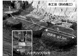
本工法を用いたフィールド実証試験
