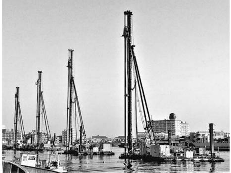
中川護岸耐震補強工事で稼働中のCDM-FLOAT工法
