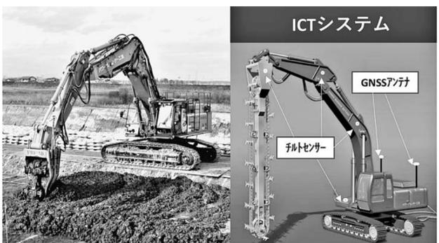
パワーブレンダー工法は、原位置土とセメント系固化材などの改良材をトレンチャック攪拌混合機にて、望ましい流動値で鉛直方向に攪拌混合しながら、水平に連続推進させる事により、互層地盤であっても改良範囲全域において均質な改良体の造成を可能とする地盤改良工法です。
