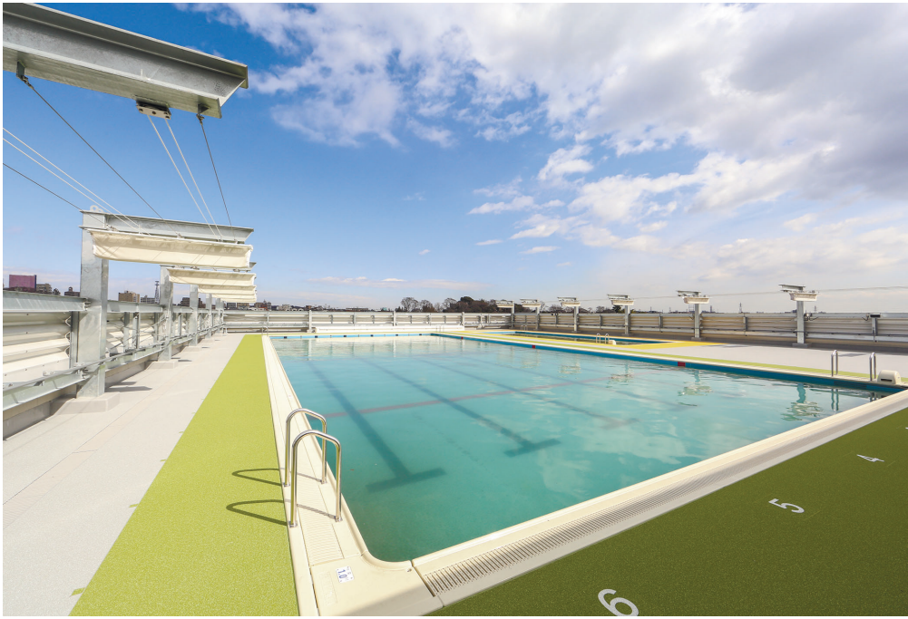
体育館棟屋上プール
