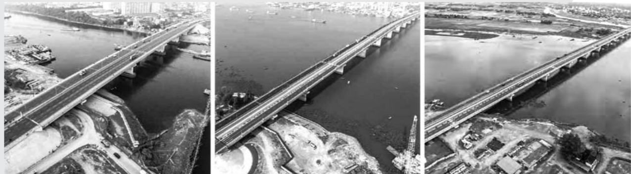
カチプール・メグナ・グムティ新橋建設及び既存橋改修工事 〈バングラデシュ〉
