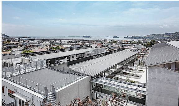
海と里山をつなぐ公民館棟と校舎棟(手前)
