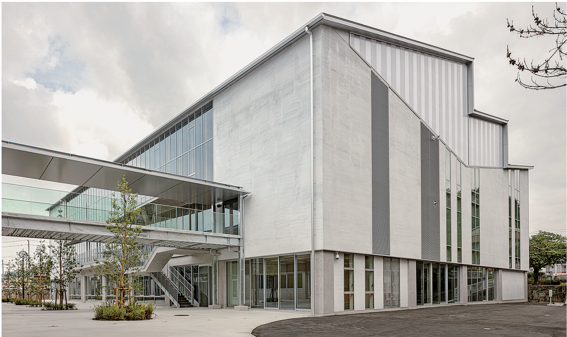
周辺工場のノコギリ屋根をデザインに反映した公民館棟
