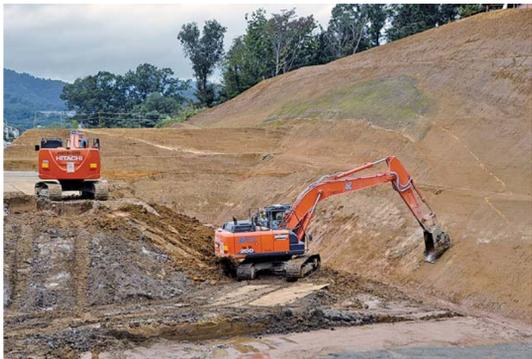
のり面整形にMC対応のバックホウが活躍する寺田地区改良その13工事の現場
