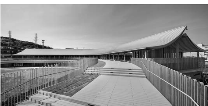
■発注者：天草市■所在地：熊本県天草市■構造：W、S、RC造■階数：地上2階■延床面積：5,453㎡■建築：吉永産業・金子産業・大昌建設JV■電気：九電工・熊電施設JV■空調・衛生：九電工・三和電工設備JV■工期：2018年10月23日～2019年12月26日 撮影＝太田拓実
