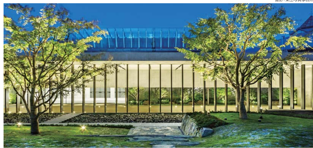
撮影:東出写真事務所
