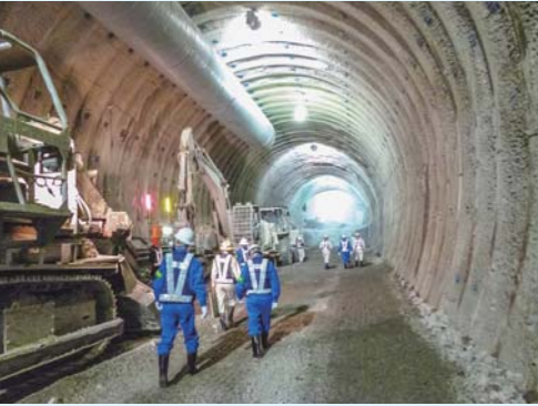
鉄道工事事故防止と現場環境保持のため定期的な安全パトロールを実施
