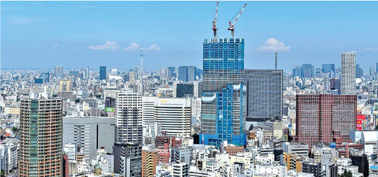
建物の省エネに設備工事は重要な役割を果たす
