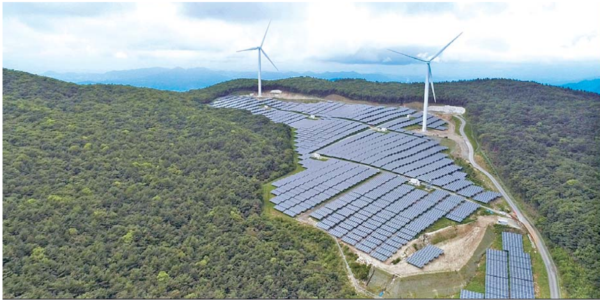
設備各社は再生可能エネルギーの普及に注力する (東光電気工事提供)
