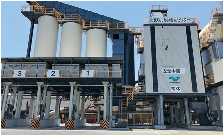
最新設備でCO 2 排出量を大幅に削減（日本道路提供）
