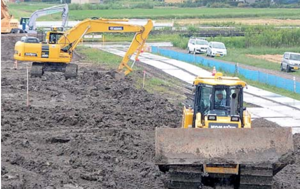
ICT施工の普及拡大に向け、国交省は取り組みを強める
