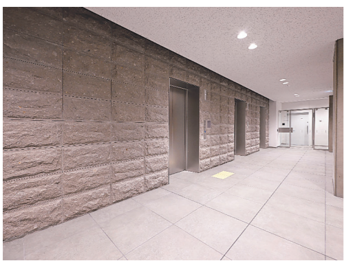
札幌軟石で覆われた1階エレベーターホール
