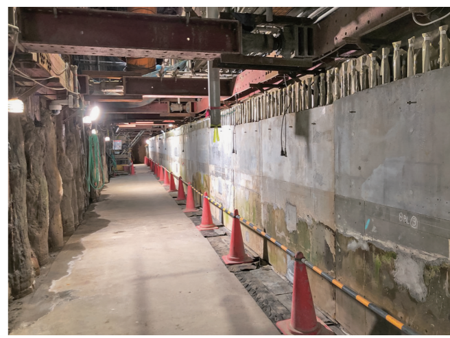
軌道下掘削・構築・埋め戻し完了
