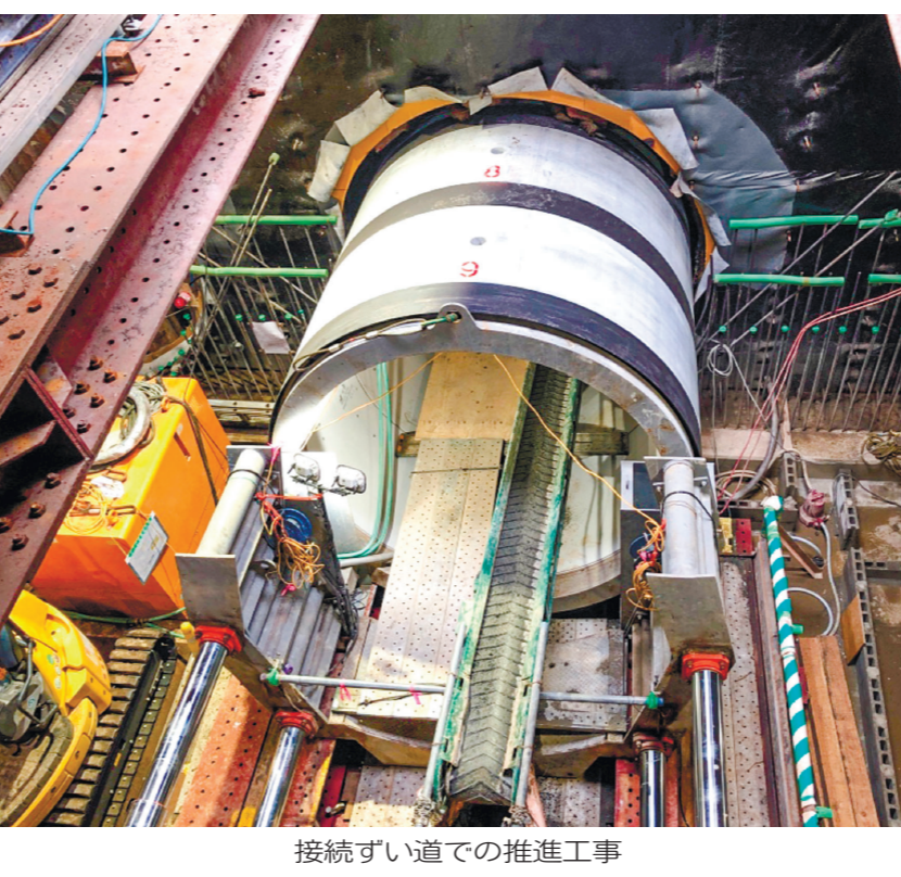
接続ずい道での推進工事
