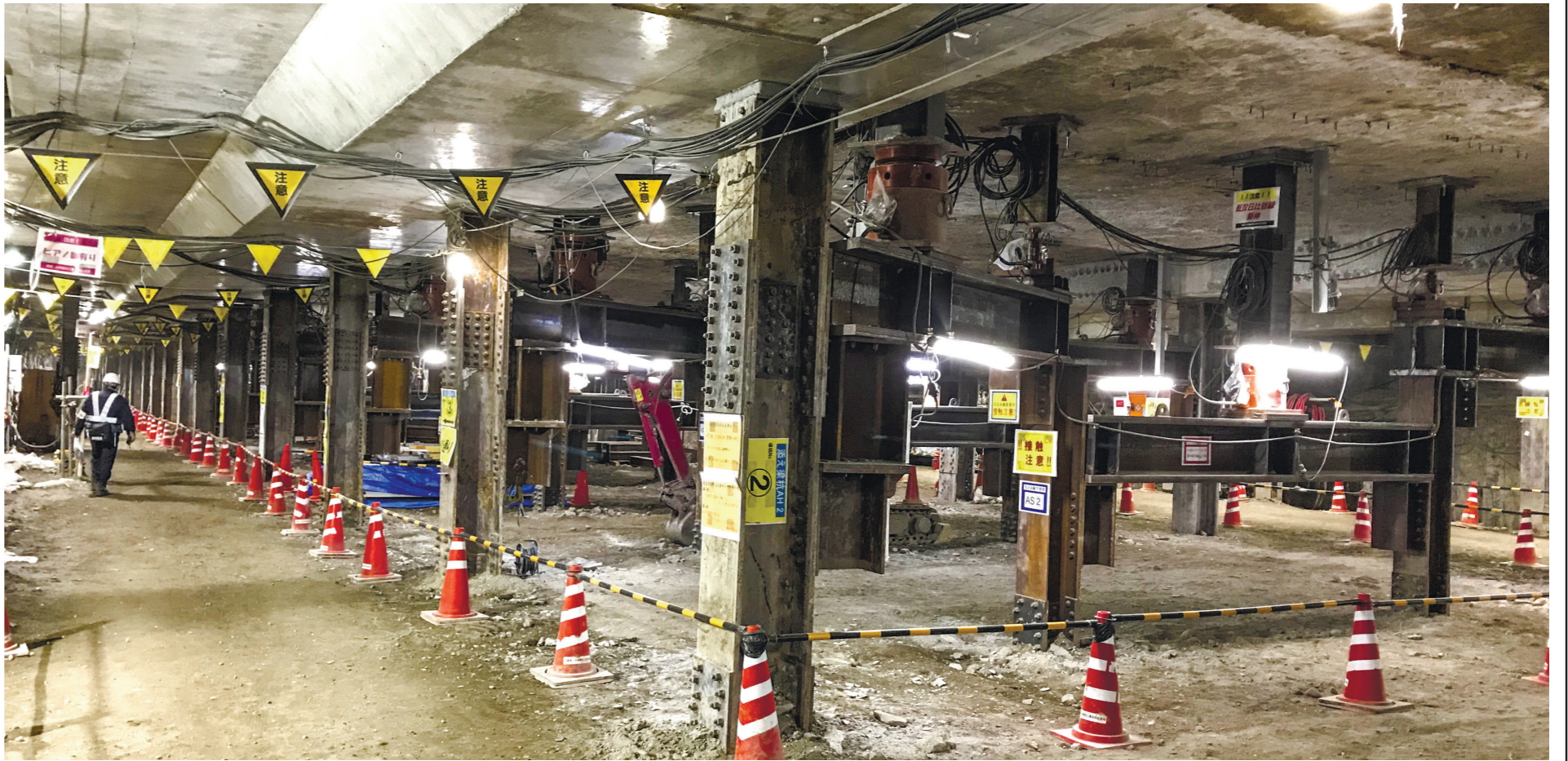
既設構造物に配慮したアンダーピニング工法
