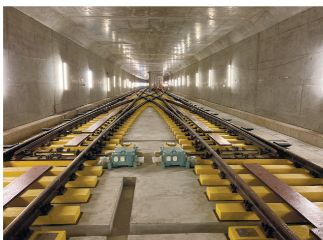
新設した折返し設備（A線空、分岐起点、B線）
