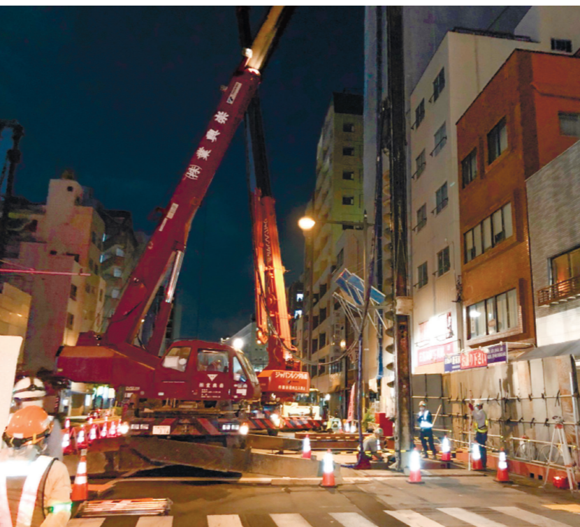
土留め杭打設
