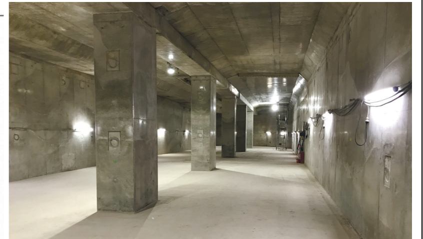
地下2階コンコース
