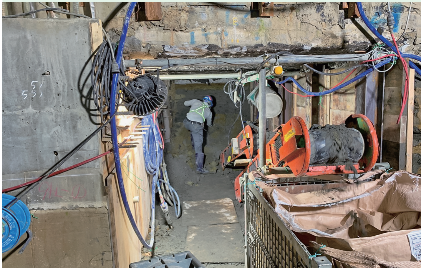
軌道下掘削状況
