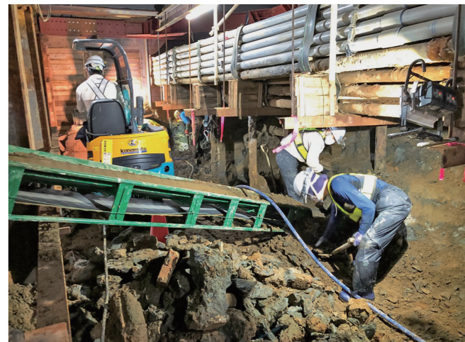
埋設管防護下掘削状況
