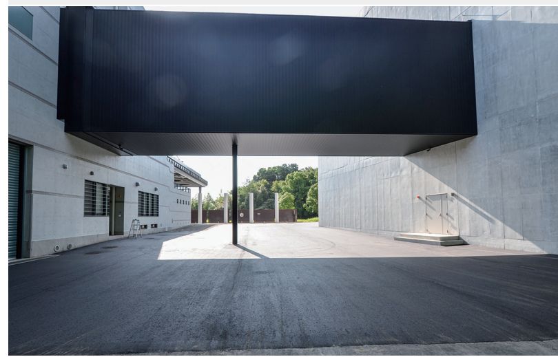
取手館と連絡するブリッジ
