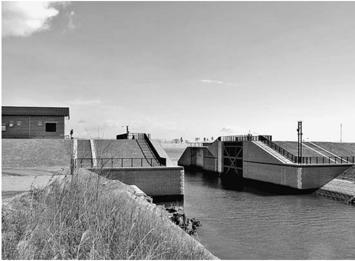
復旧した野蒜水門(宮城県東松島市)
