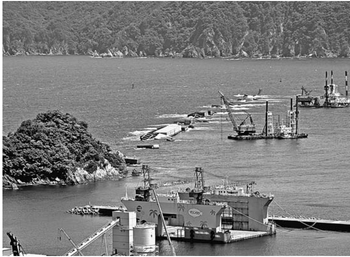
釜石湾港防波堤の修復(岩手県釜石市)
