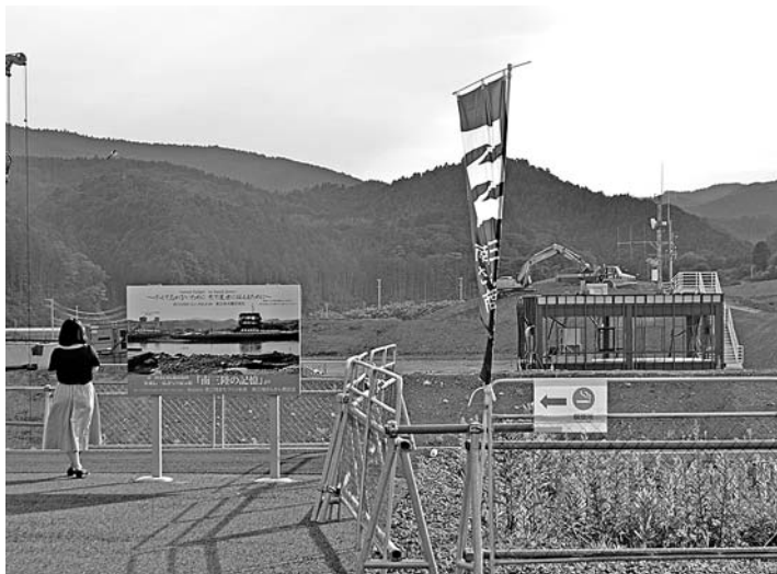
南三陸町旧防災対策庁舎(宮城県南三陸町)
