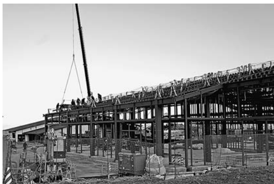
大熊町の大川原地区で建設が進む交流施設(2月撮影)
