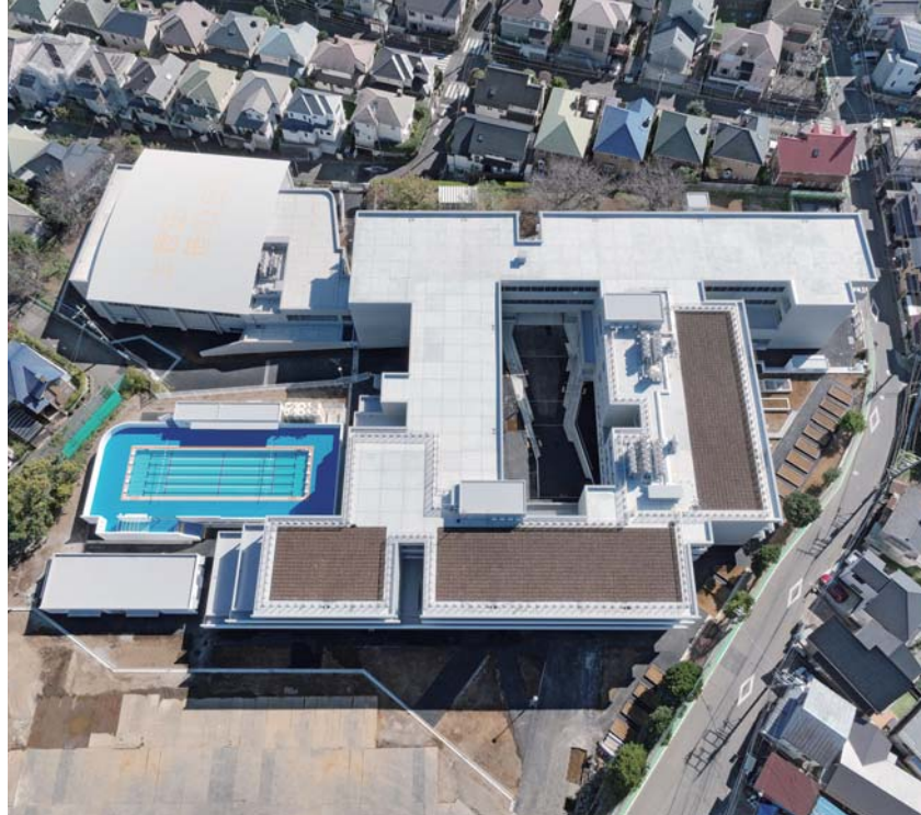
上空から見た外観
