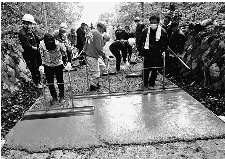
学生たちがコンクリート舗装を体験する(福島県平田村で、岩城一郎教授提供)
