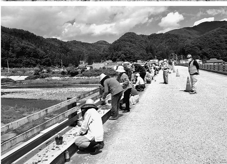
住民が学生と協働して橋の欄干を塗装する(福島県南会津町で、岩城教授提供)
