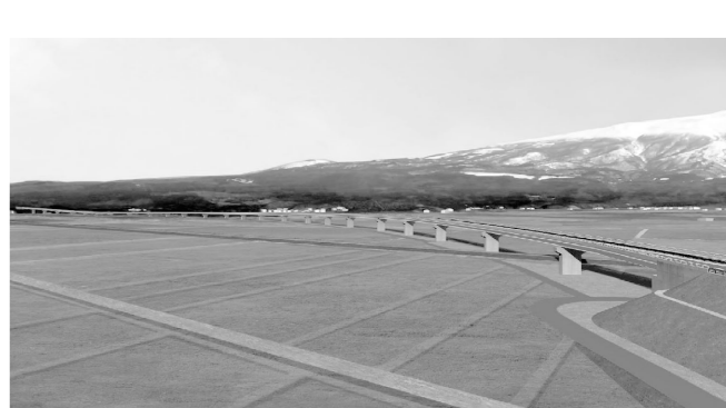
吹浦高架橋全景完成イメージ(提供-国土交通省東北地方整備局酒田河川国道事務所)
