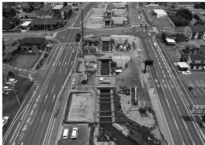
現場全景(万国橋側)
