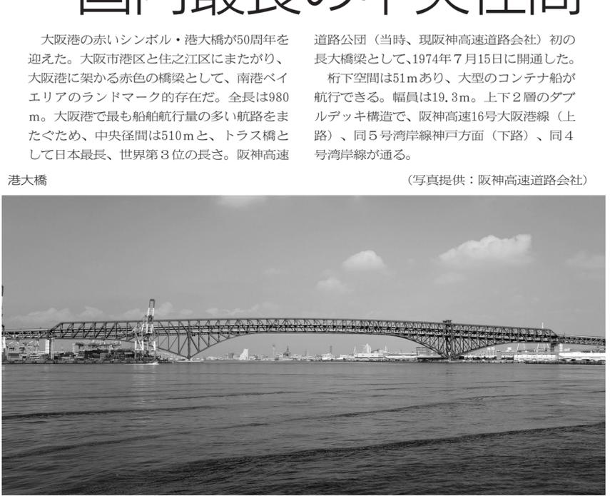
大阪府の赤いシンボル・港大橋が50周年を迎えた。大阪市港区と住之江区にまたがり、大阪港に架かる赤色の橋梁として、南港エリアのランドマーク的存在だ。全長は980m。大阪港で最も船舶航行量の多い航路をまたぐため、中央径間は510mと、トラス橋として日本最長、世界第3位の長さ。阪神高速
