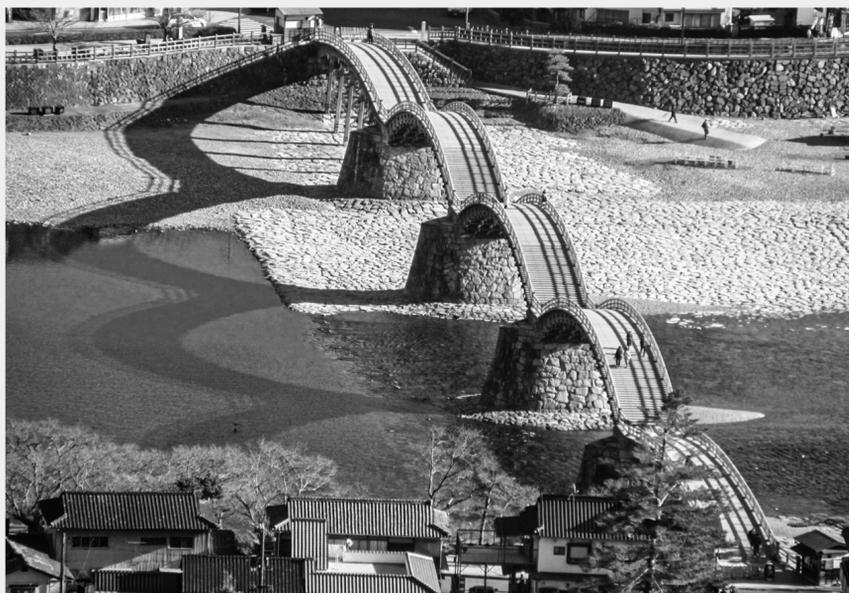
全長193.3mの木造アーチ橋。5連のうちスパン約35mの中央3連がアーチ。1673年、岩国第3代藩主の吉川広嘉によって架橋するが数ヶ月で流失。改良を加えて翌年再建。1950年のキジア台風による洪水で流失するまで、架け替えを繰り返しながら276年間人々の往来を支えた。1953年、再々建。
