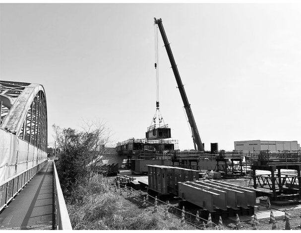
クレーンによる架設作業
