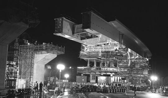
多軸台車による一括架設(①ブロック)
