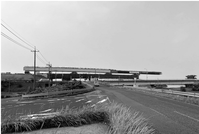
橋桁の架設状況
