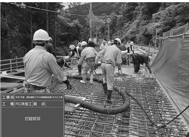
R C床版工
