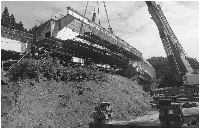
架設状況②
