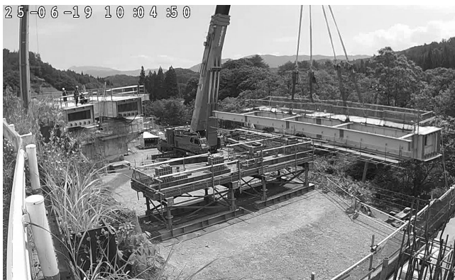
架設状況①
