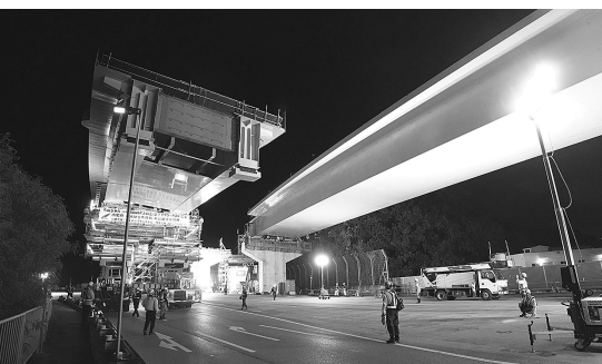
多軸台車による一括架設(②ブロック)
