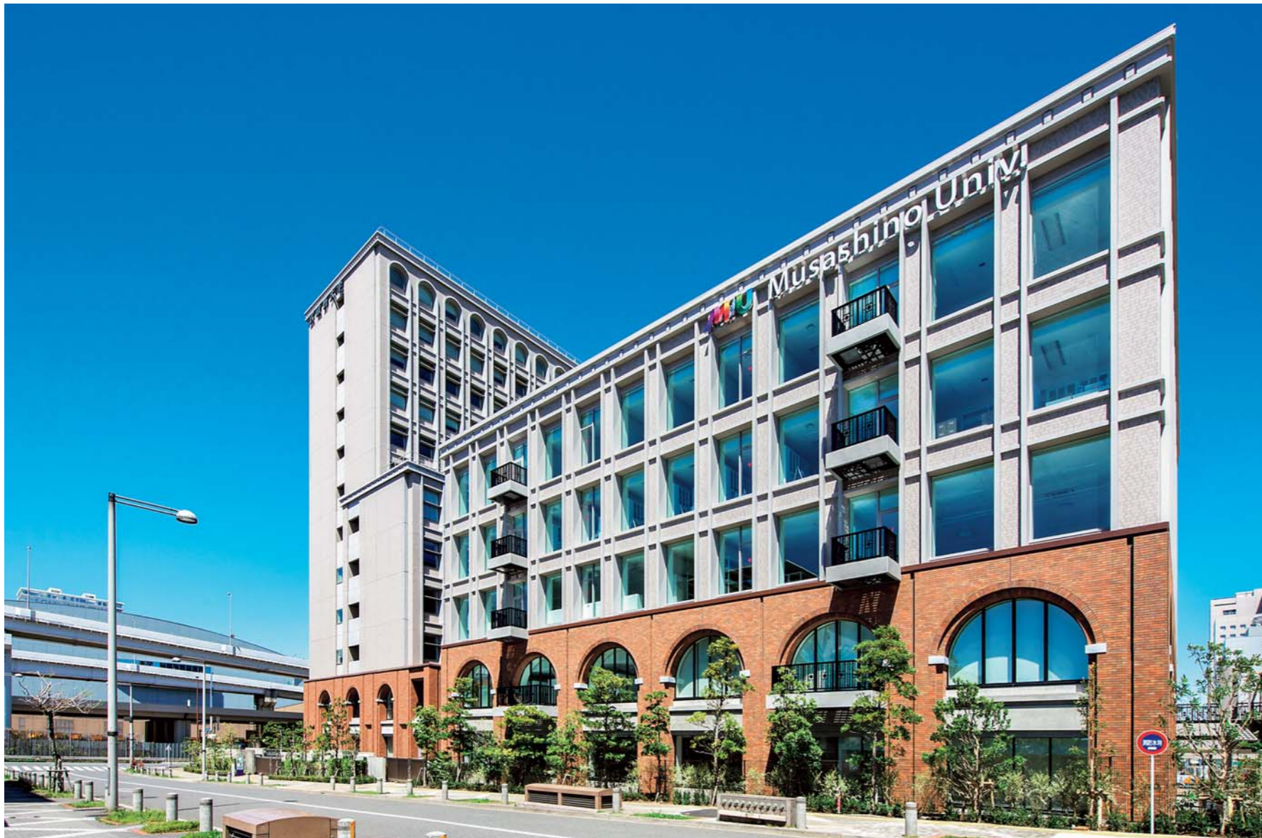
既存建物のデザインコードを継承したファサード
