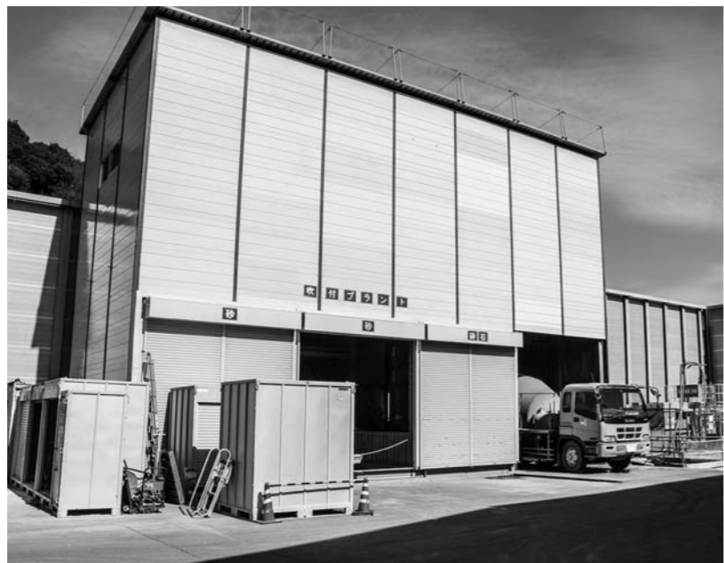
吹き付けプラント
