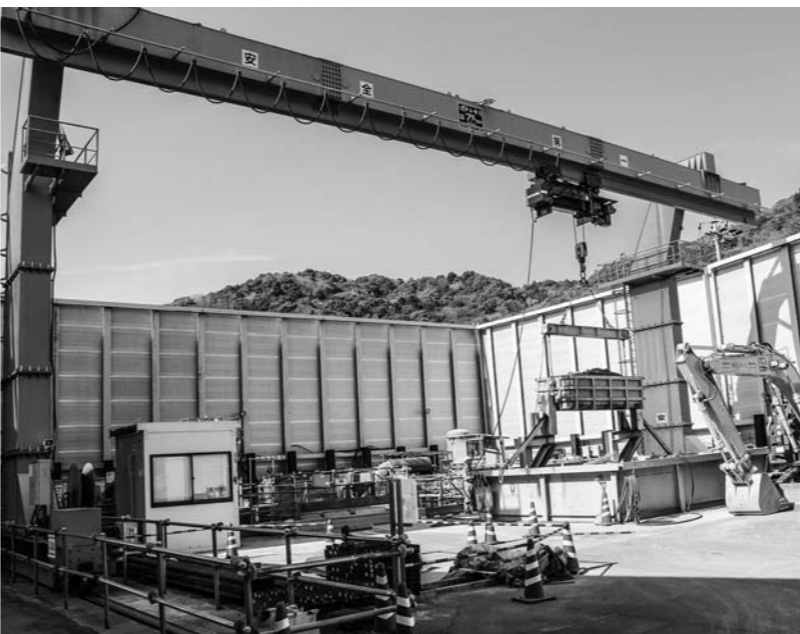
橋型クレーン
