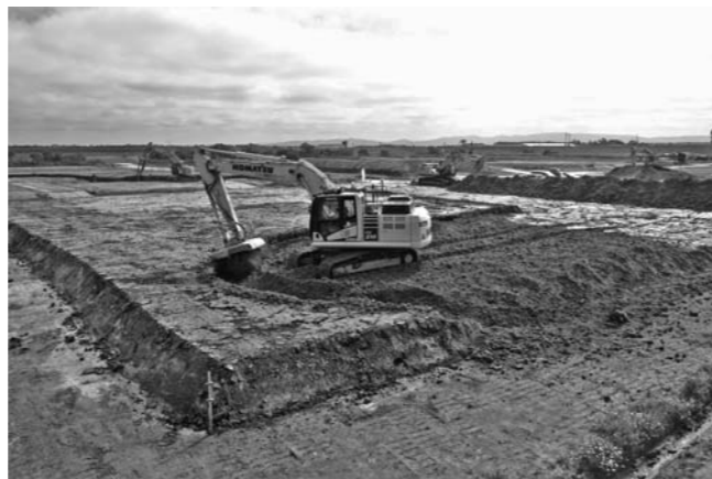
粘性土と砂質土の混合攪拌による盛土材料製造
