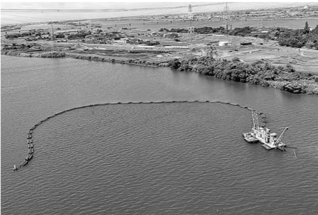
稼働するポンプ浚渫船
