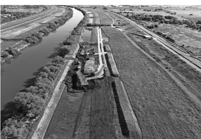
ICTによる上流区 掘削状況
