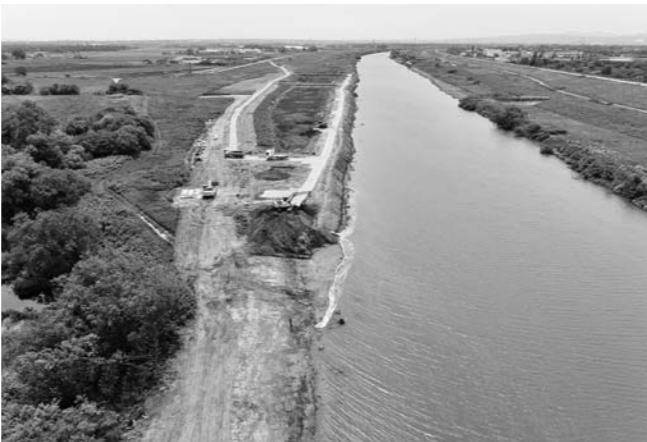
ICTによる下流区 掘削状況
