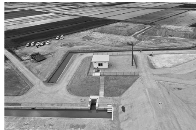
完成した舞野揚水機場
