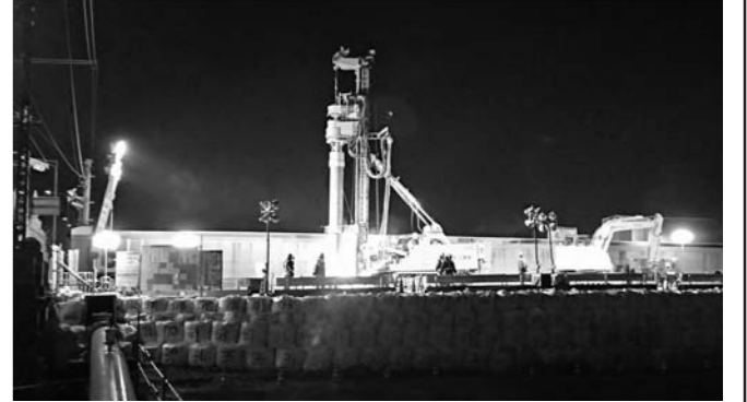
鋼管杭打設状況
