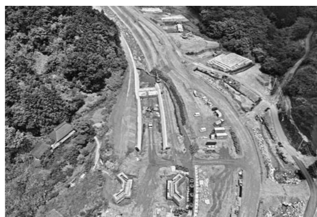
改良復旧状況(2021年5月乙石川下流より)
