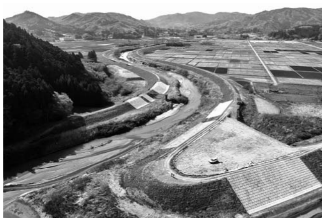
内川その1工区下流側
