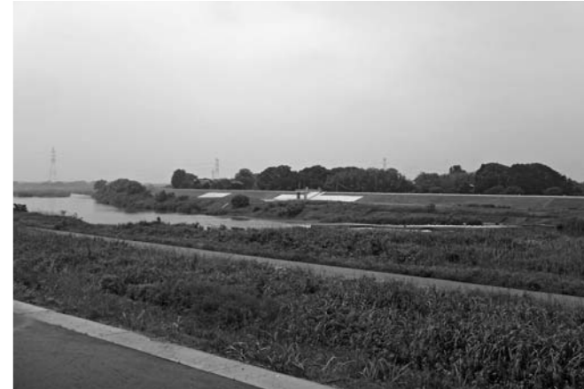
完成した現場(左岸から臨む)
