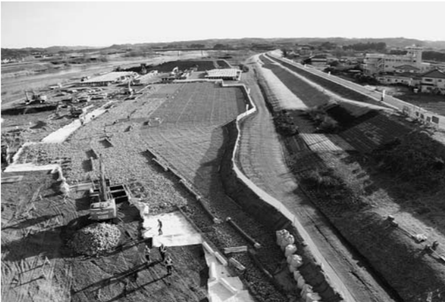
かごマット施工状況
