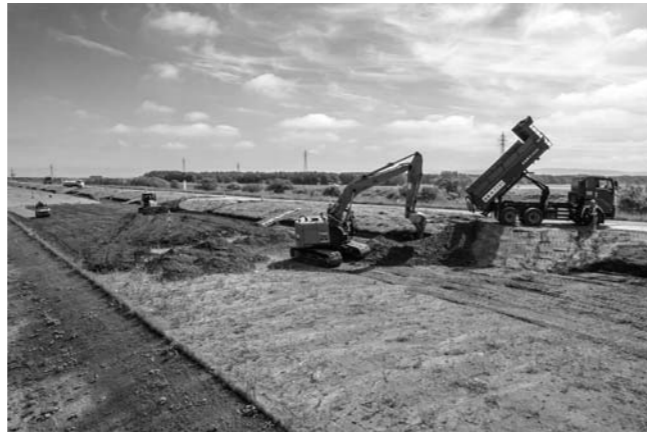
路体(築堤)盛土工状況
