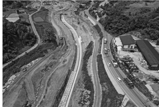
改良復旧状況(2021年5月赤谷川上流より)
