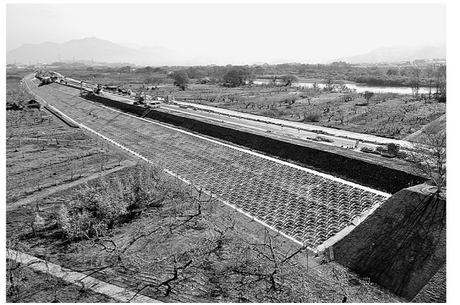
大型連節ブロック張の様子
