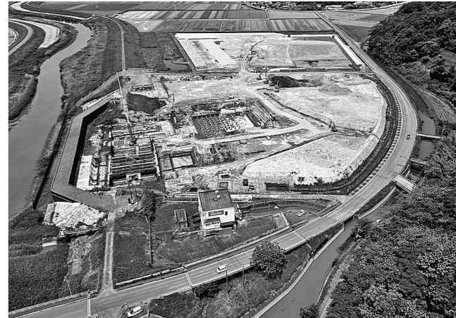
コンクリート工事が本格化する現場
