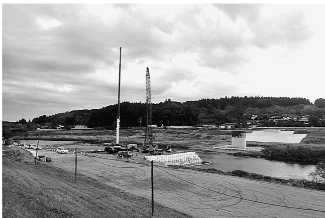
鋼矢板圧入状況
