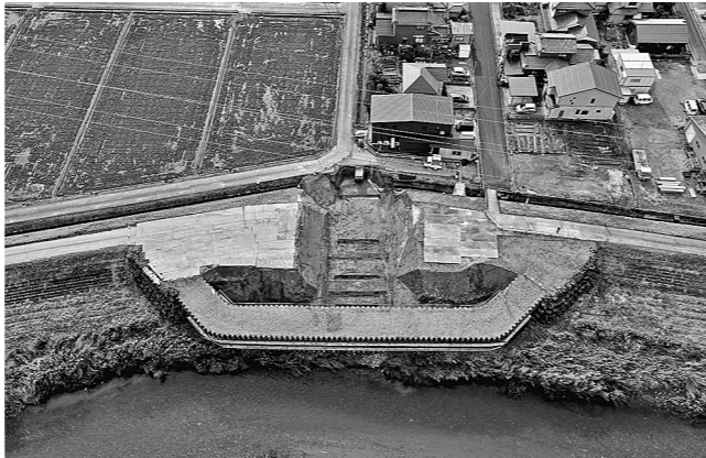
堤防開削、仮締切の様子
