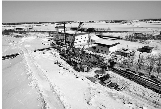
PHC杭打設の様子
