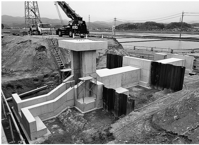
埋戻し前の樋管部の状況
