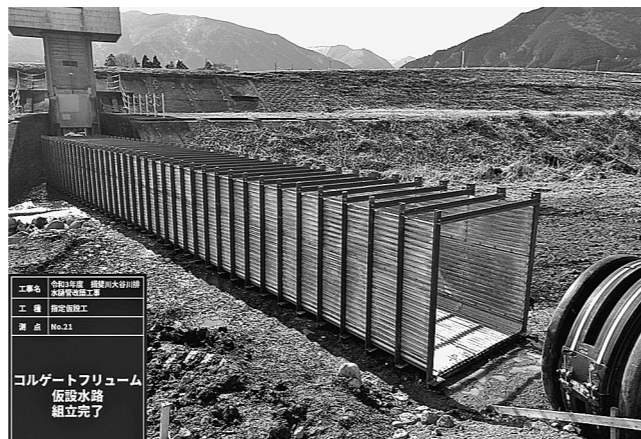
組み立てが完了したコルゲートフリーウム仮設水路
