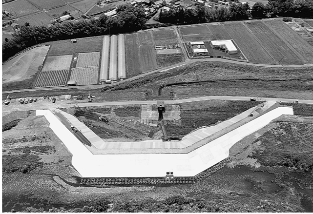
仮締切盛土全景
