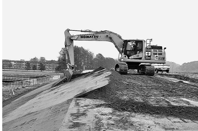
ICT法面整形
