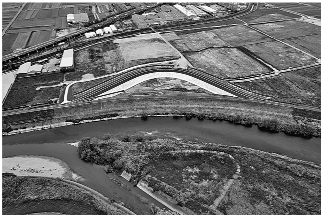
迂回道路の川側に樋門・樋管を設置
