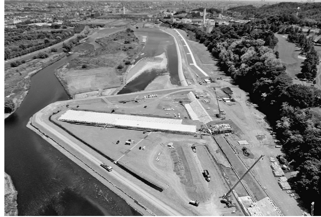
右岸上流から見た現場の状況
