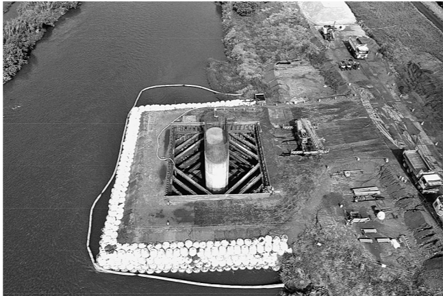
躯体工完了時
