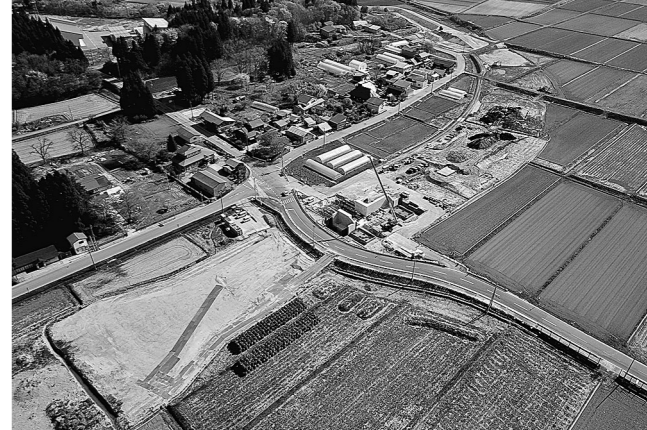
工事の施工状況。国道の切り回しが完了し陸間の構築が進む
