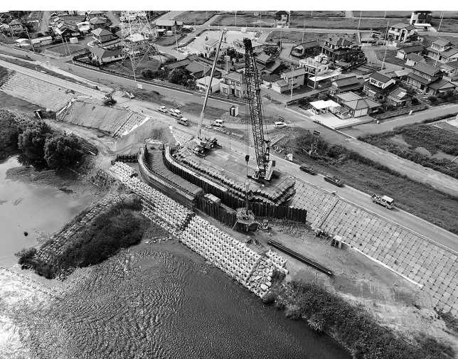
桜佐排水樋管撤去部の仮設堤防構築位置
