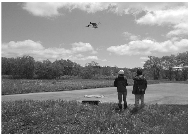
UAVによる起工測量
