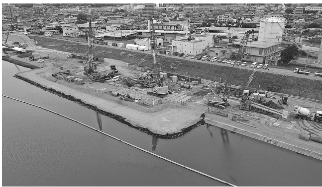
場所打ち杭施工状況
