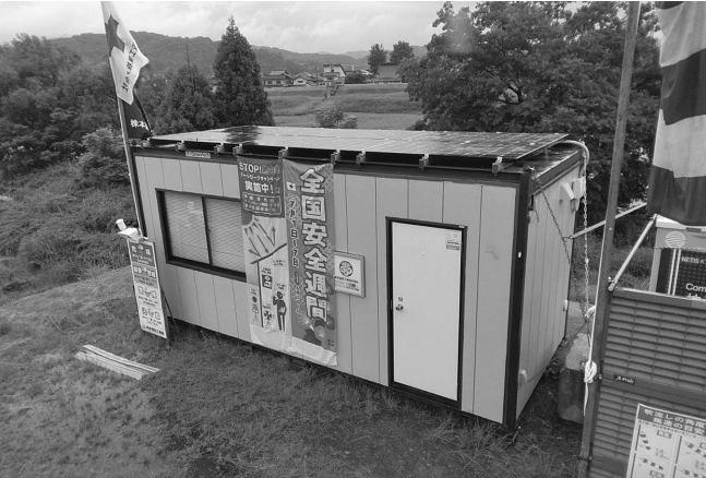
太陽光電源を備えた休憩所
