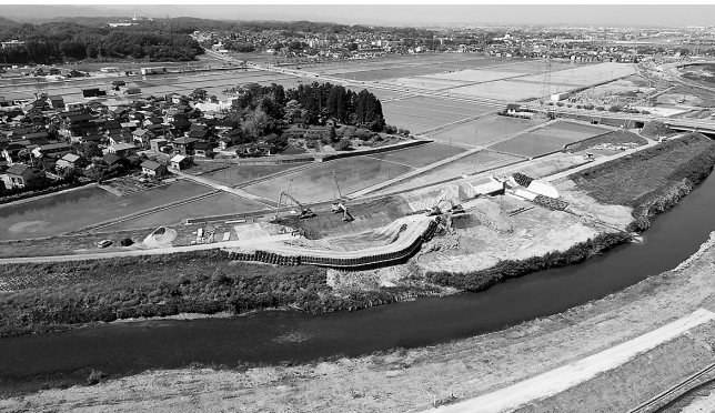
現場の施工状況
