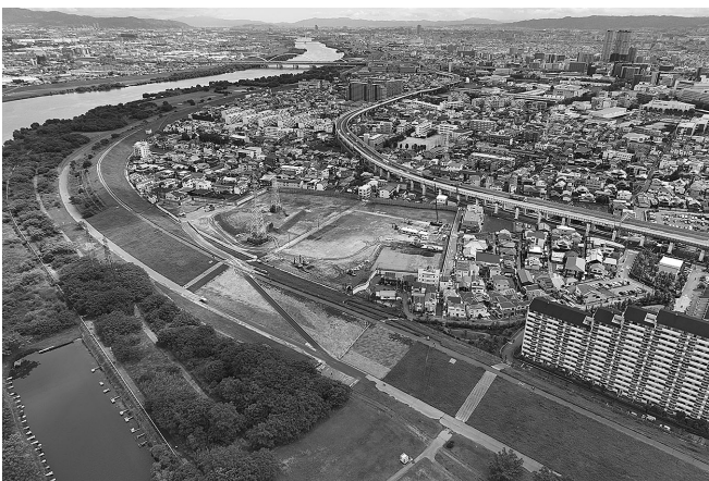
淀川の高規格堤防事業(下島地区)の全景
