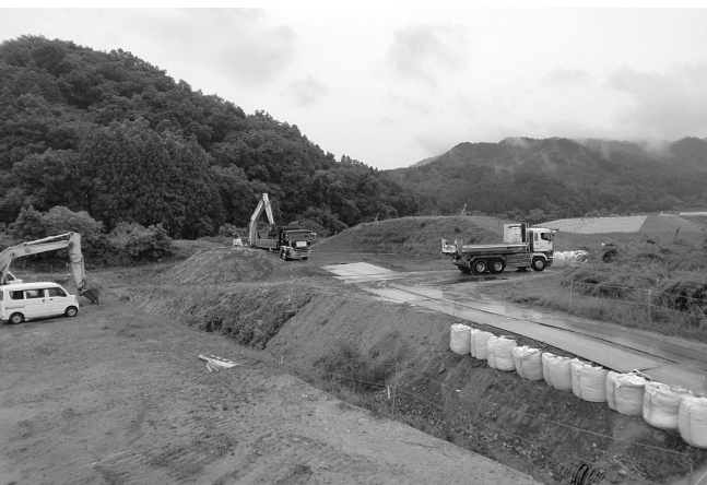
施工準備が進む現場
