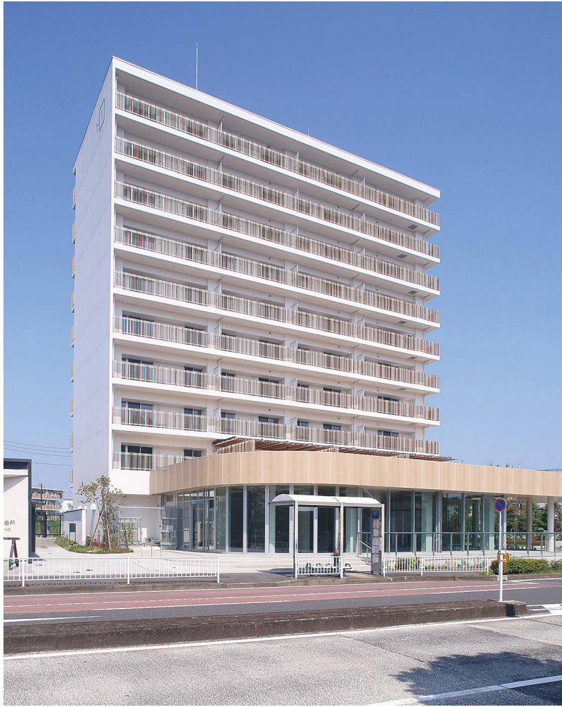
洋光台通りからの全景
