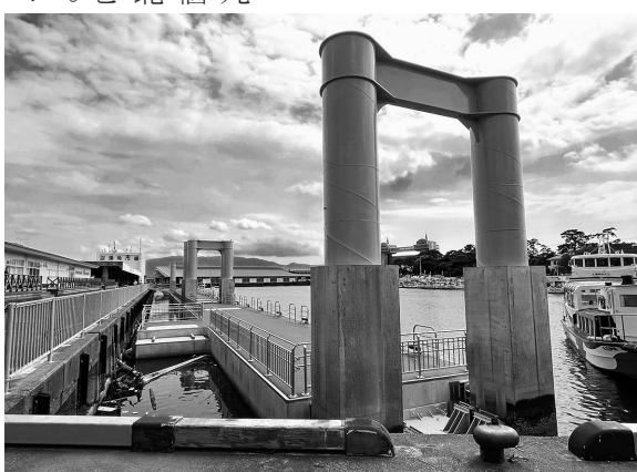
会場となる沼津港(静岡県提供) 内港で整備中の浮き橋
