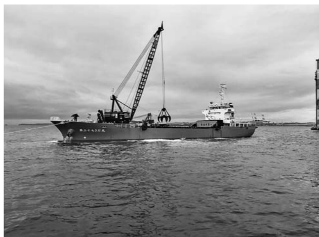
基礎工 捨石投入状況
