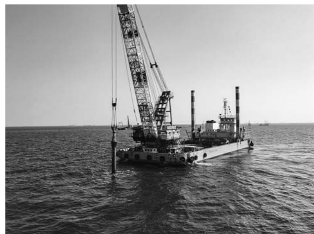
基礎工 捨石本均し状況
