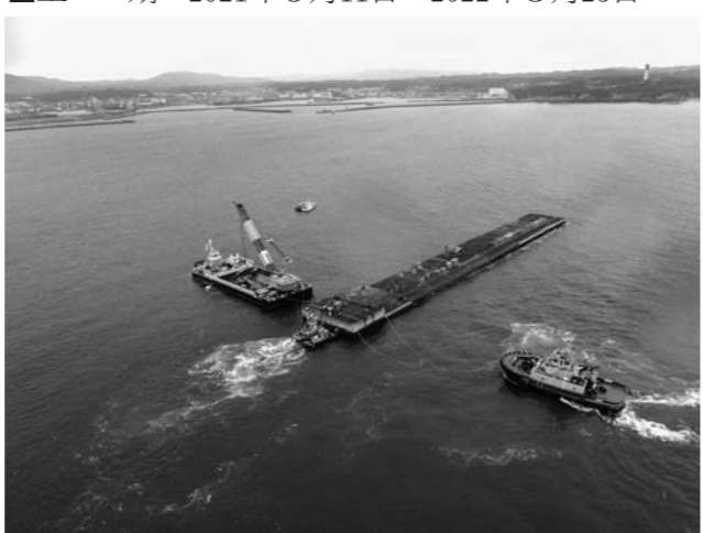
ケーソン据付状況
