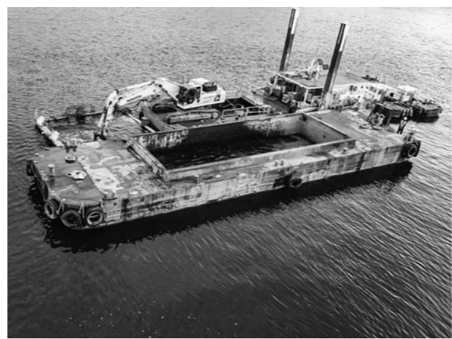
上空から見た施工状況
