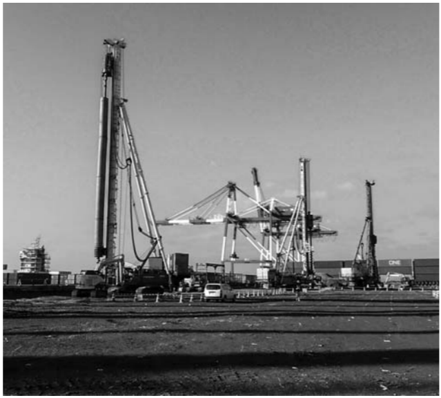
陸上地盤改良工 施工状況
