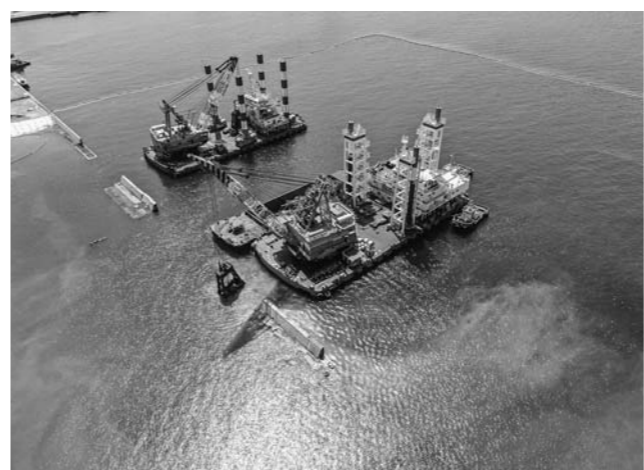
作業船「拓海」で行うケーソン破砕の状況
