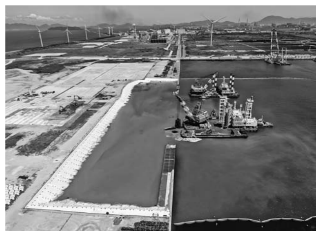
作業船「拓海」で行うケーソン破砕の状況
