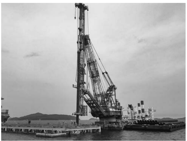
鋼管杭打設
