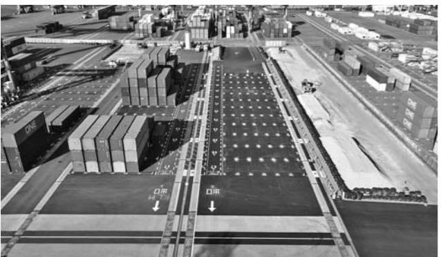
コンテナターミナルを供用しながらの施工
