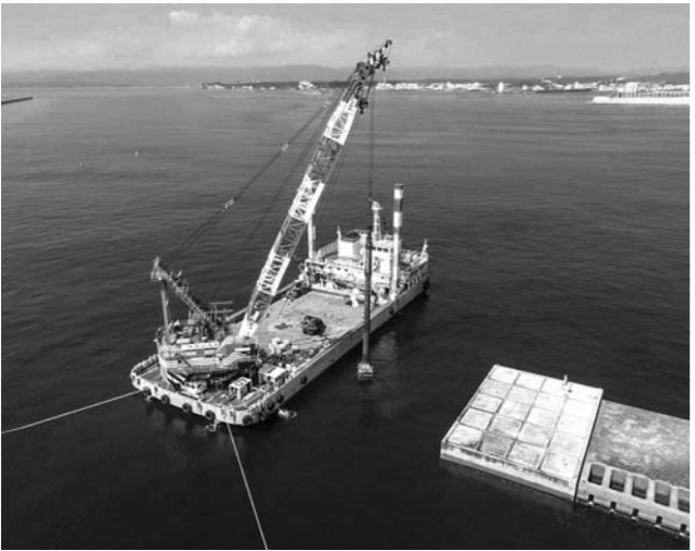
基礎捨石本均し状況
