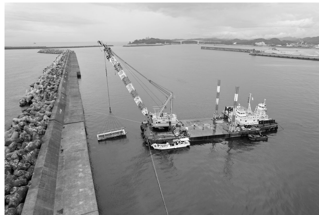
アスファルトマット敷設
