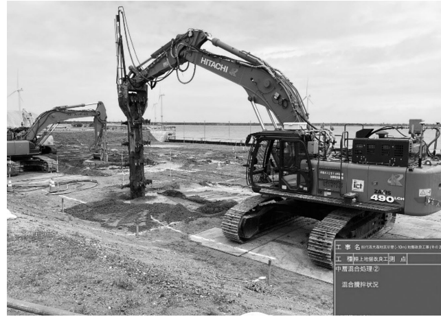
ICT搭載の施工機械による改良作業
