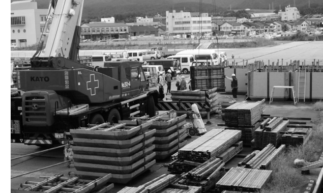
型枠の大組み状況
