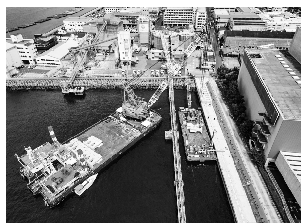
起重機船による直立消波ブロック据え付け状況
