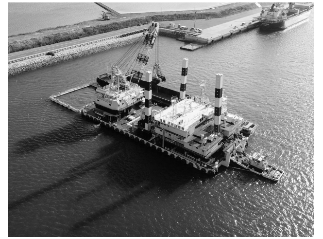
クラブ浚渫船による床掘り
