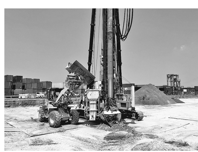
サンドコンパクションパイル材料投入状況
