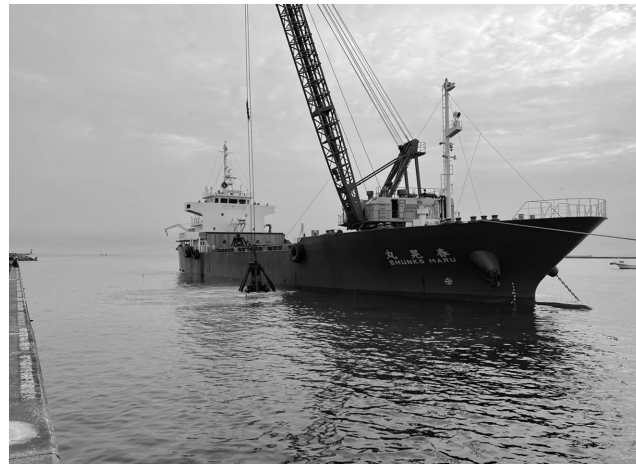
基礎捨石投入状況
