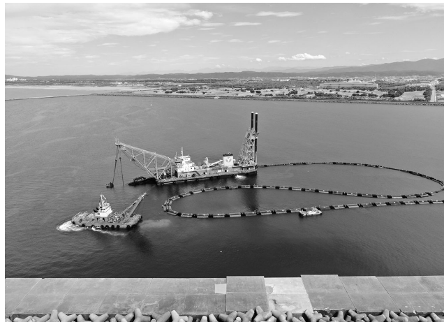
ポンプ浚渫船「筑波丸(8000ps)」の施工状況
