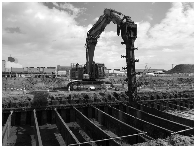
中層混合処理施工状況
