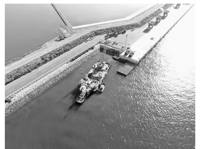
既設ケーソン周辺の雑石撤去
