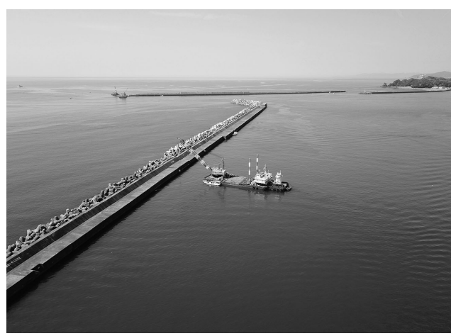
被覆ブロック撤去
