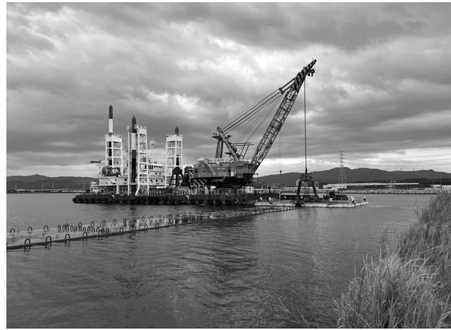
盛り上がり土砂撤去状況
