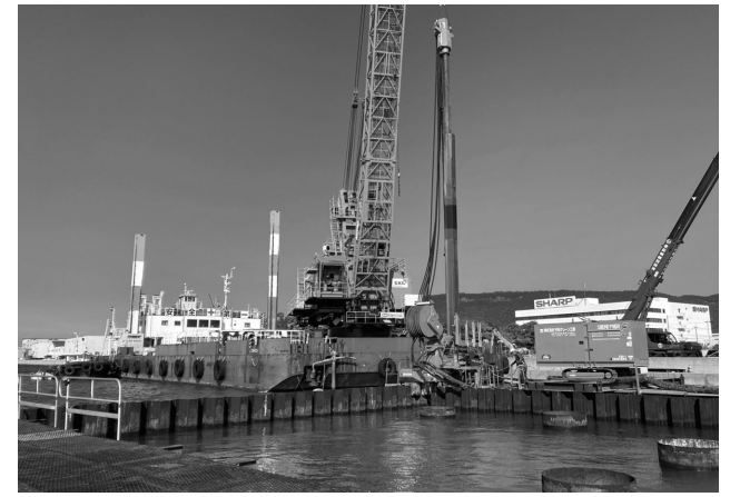
本体工鋼矢板
