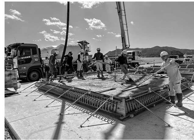
RC床版コンクリート打設
