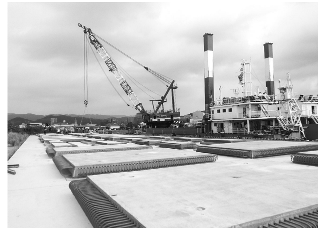
起重機船によるRC床版転置作業
