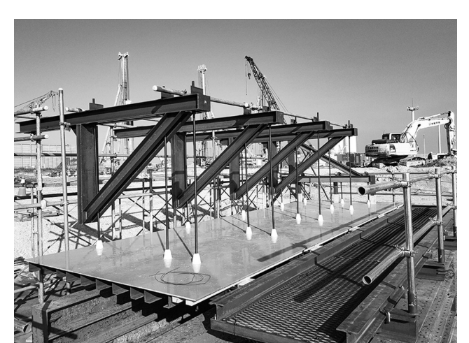
吊下げ型支保工
