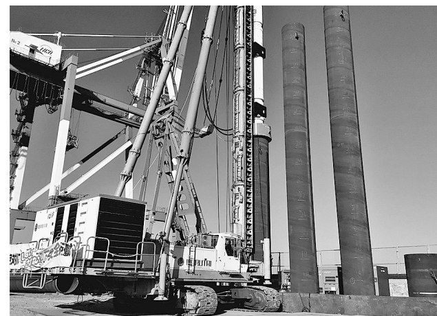
鋼管矢板打設状況
