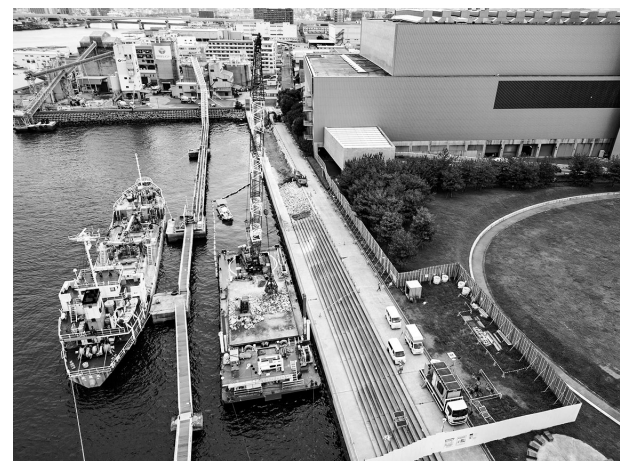
クレーン付き台船による基礎捨石投入状況
