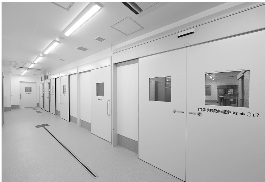
エレベーターで2階に上げた材料を各処理室に振り分ける
