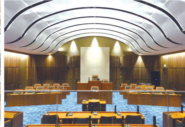
三軸織物の膜天井を使用した議場
