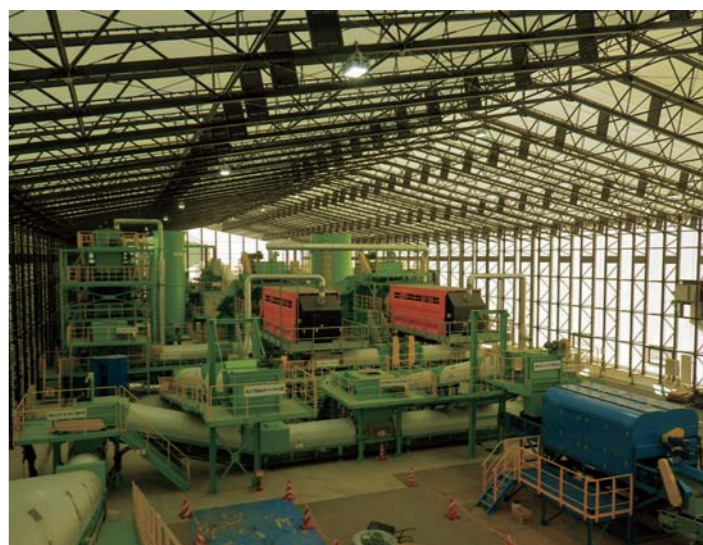
受入・分別施設処理 建屋内部
