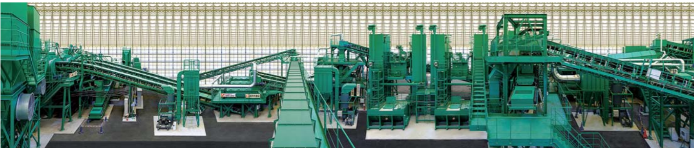
受入・分別施設全景
