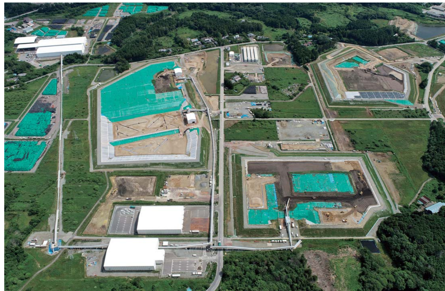
4工区 現場全景
