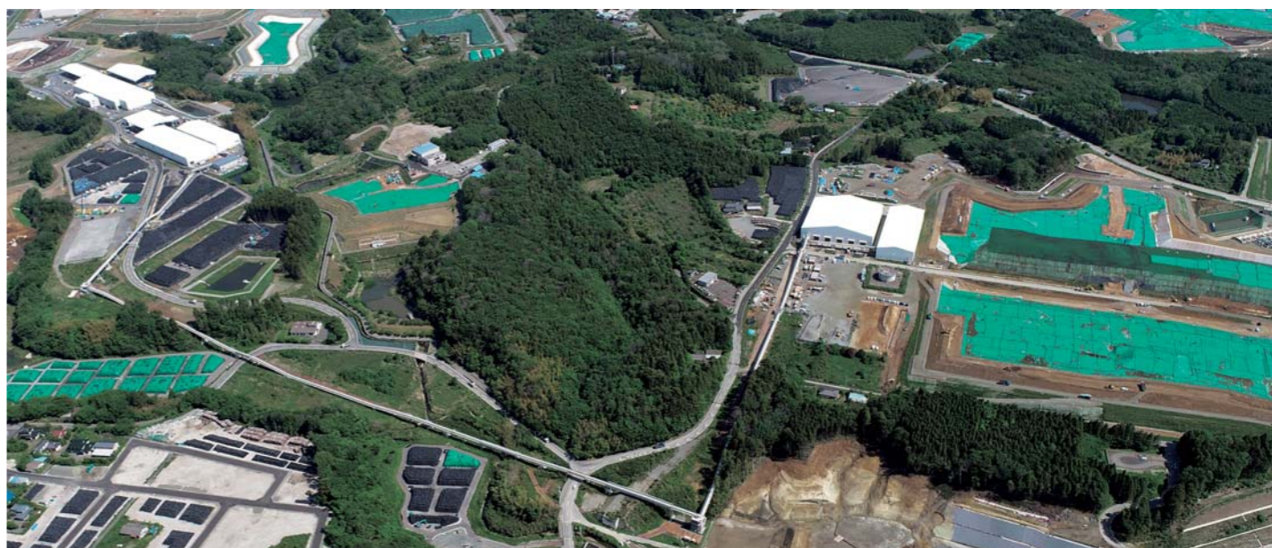
2工区 受入分別施設～土壌貯蔵施設
