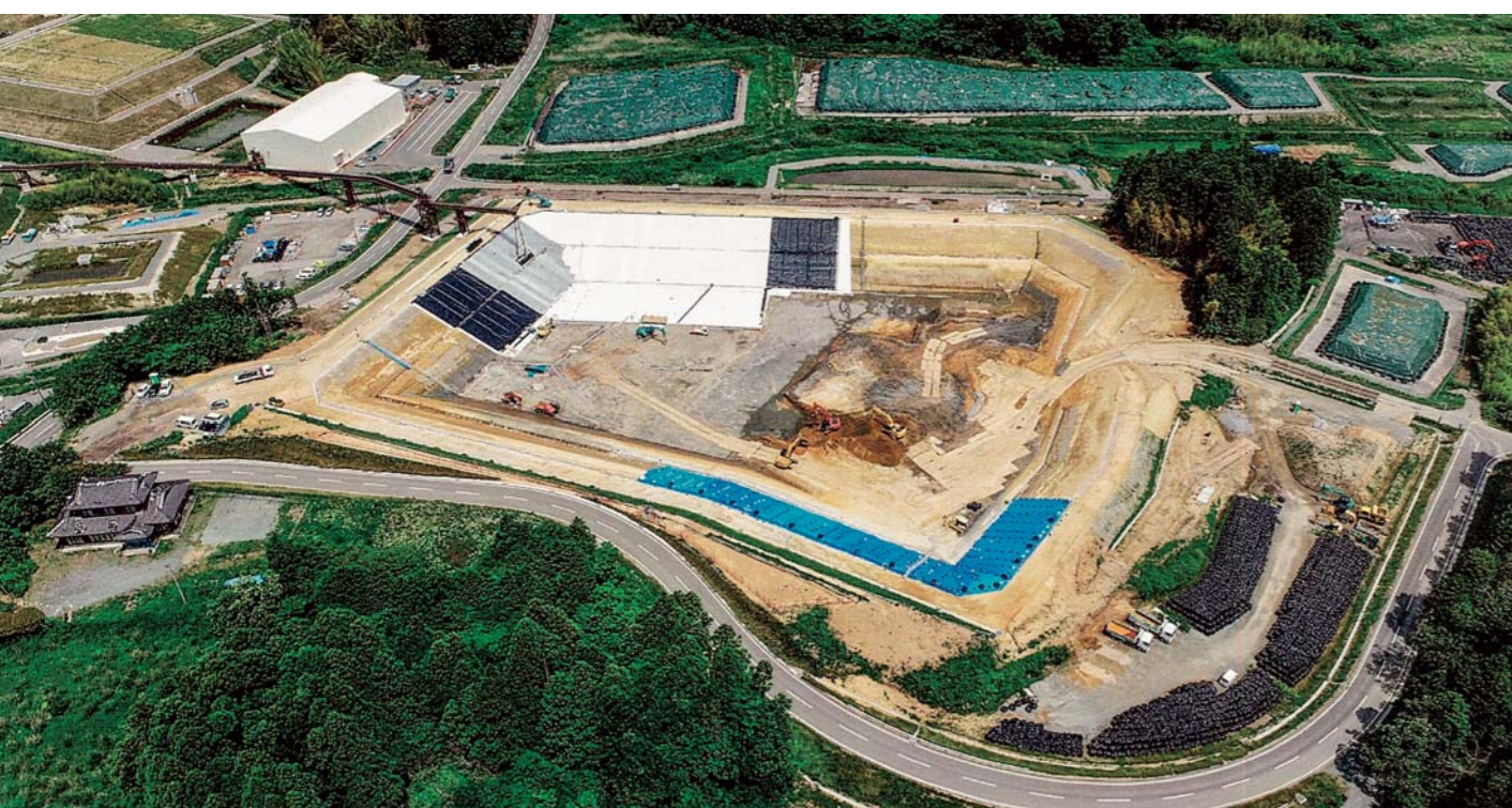
造成が終わり、遮水シートの設置工事が行われている東側区画
