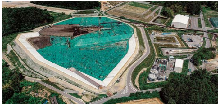
除去土壌の貯蔵が進む西側区画
