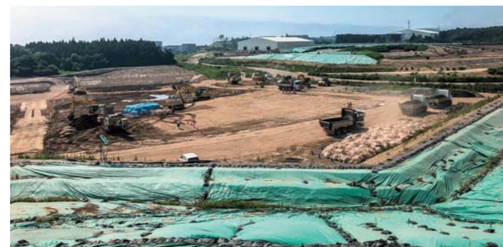
土壌貯蔵施設造成工
