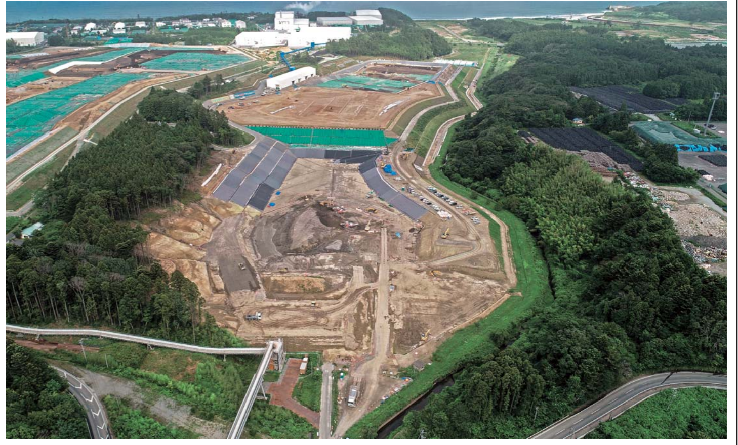
土壌貯蔵施設全景
