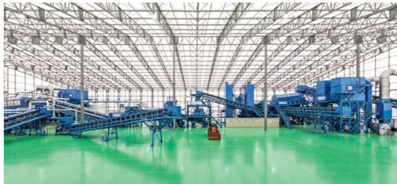
受入・分別施設全景
