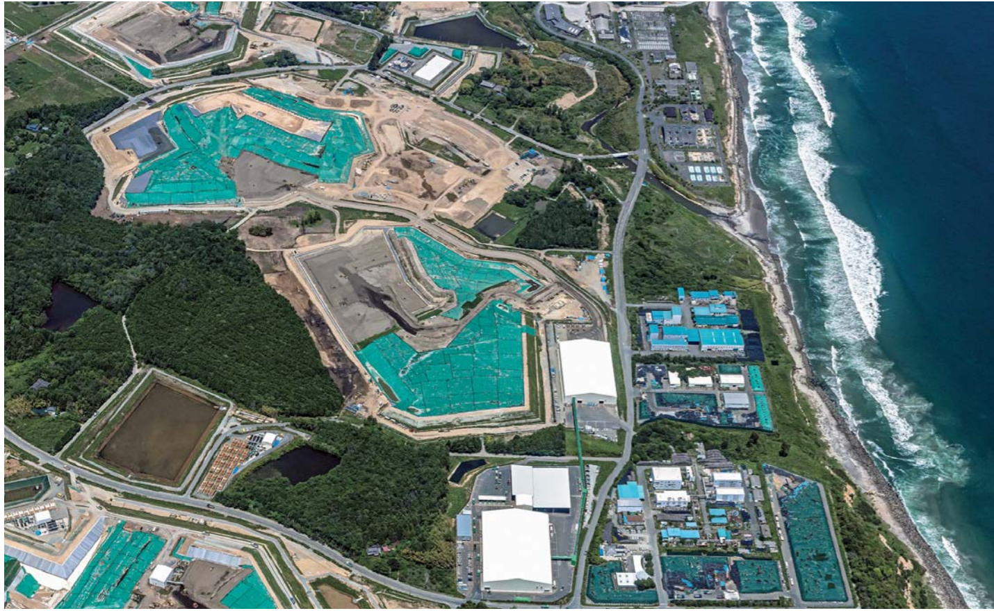
貯蔵施設全景
