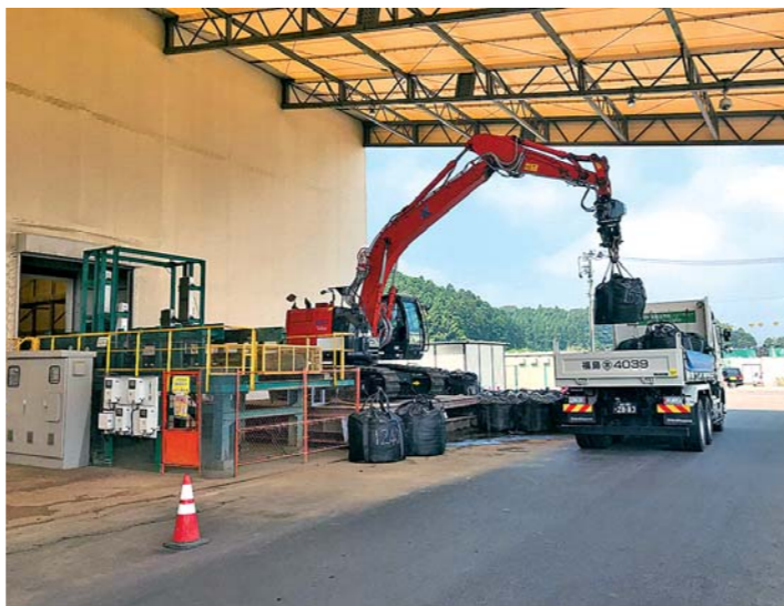
フレコン吊専用重機
