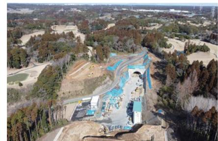
芝山トンネル(仮称)は延長616mで計画され、砂質土を主体として形成された地質構造の地山をNATMで掘削している。土壁は全線において約3mの厚さ程度と小さく、掘削土は砂子の細かい砂りょうの砂。圏央道の千葉区間ではしばしば見られる地質で、過去にも別の工事において流砂現象や陥没などが発生した。
