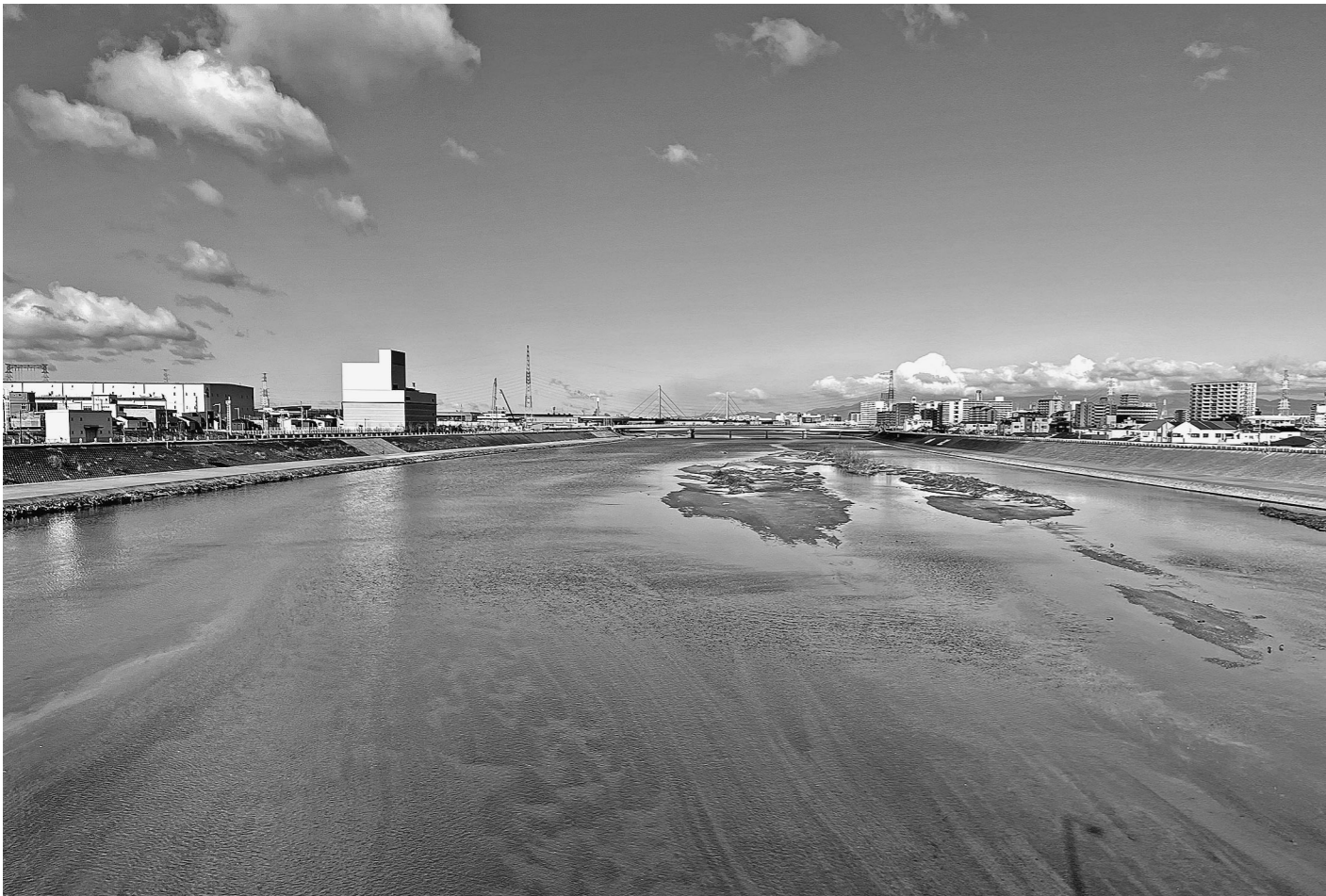
大和川の下流部(大和川大橋から下流を望む)
