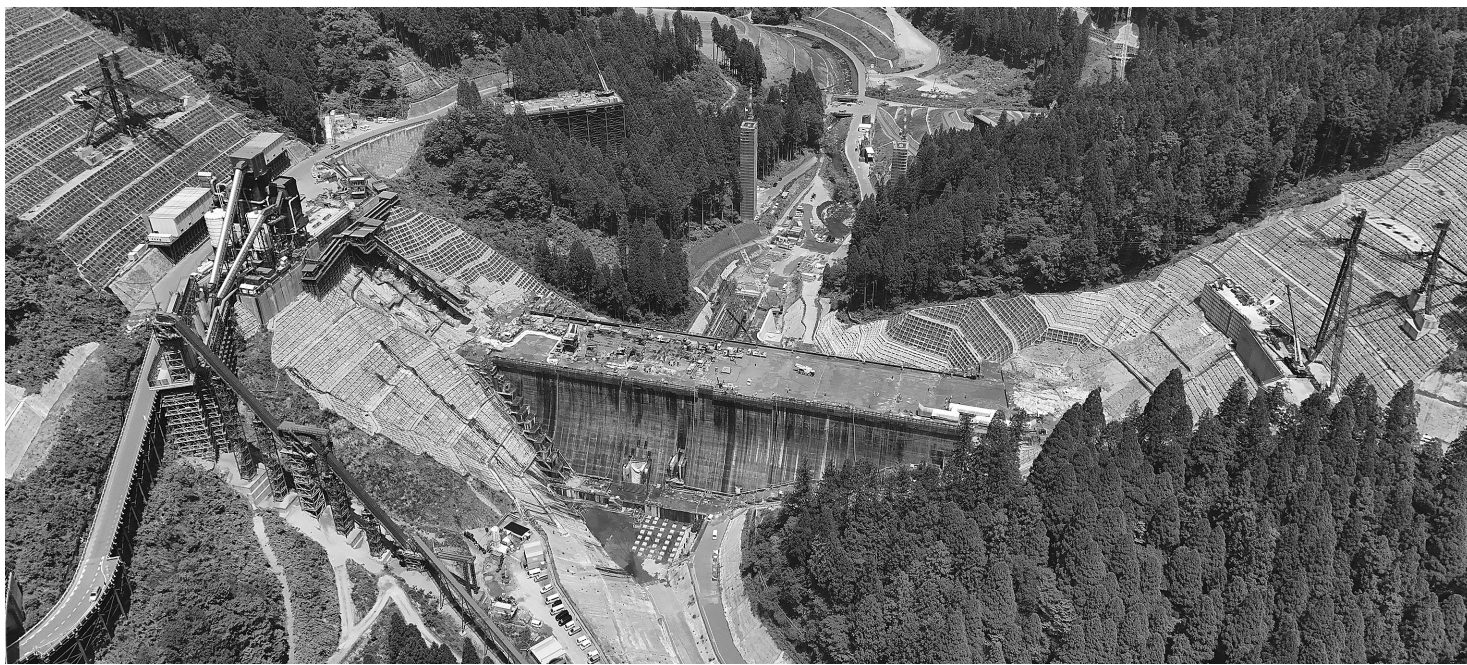
工事が最盛期を迎えた足羽川ダム
