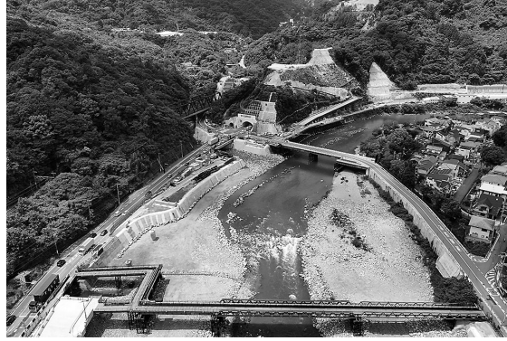
工事が進む国道176号名塩道路
