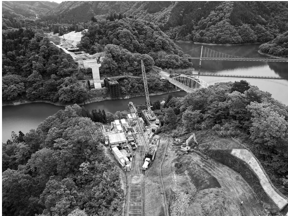
建設が進む大野油坂道路新子馬巣谷橋
