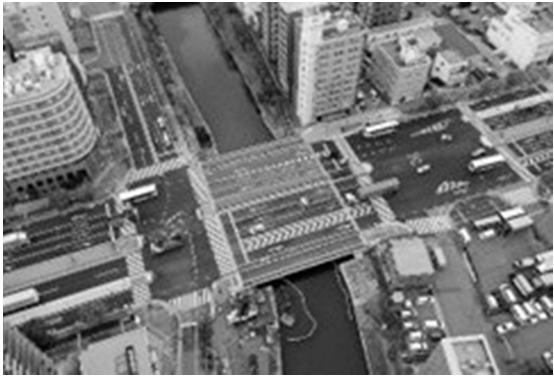
架け替えが完成した国道26号住吉橋
