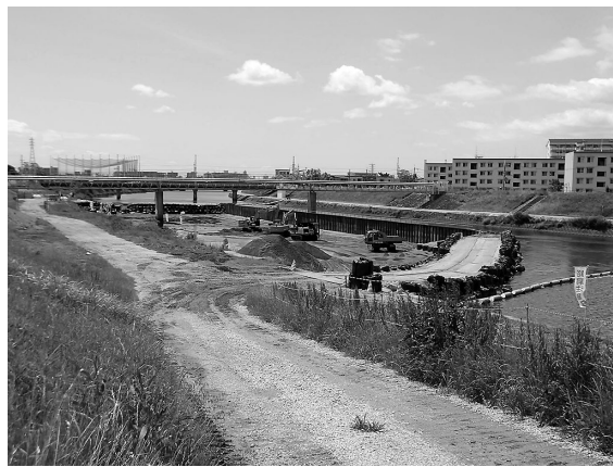
猪名川東園田地区の河道掘削
