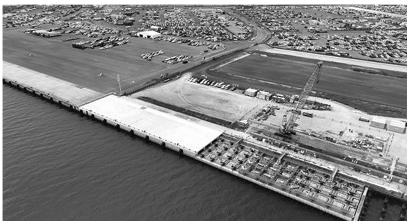
岸壁工事を推進中の堺泉北港
