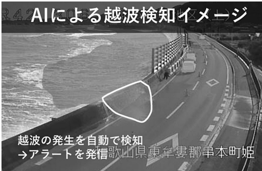
越波検知システム
