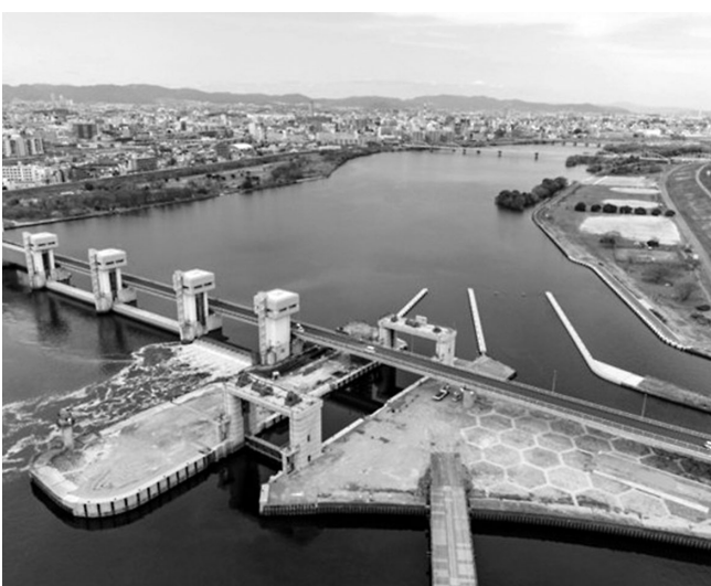
運用を開始した淀川ゲートウェイ(大堰開門)
