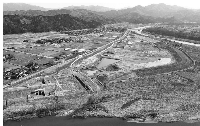
整備が進む中郷遊水地事業(兵庫県豊岡市)
