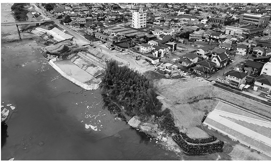
加古川改修工事(加東市滝野地区の築堤状況)
