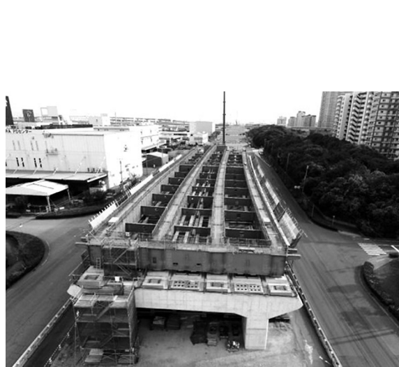
大阪湾岸道路西伸部橋梁上部工
