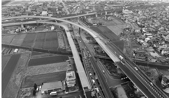
橋梁上部工進む大和御所道路(橿原市新堂)
