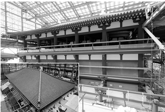
復原工事が進む第一次大極殿院東楼
