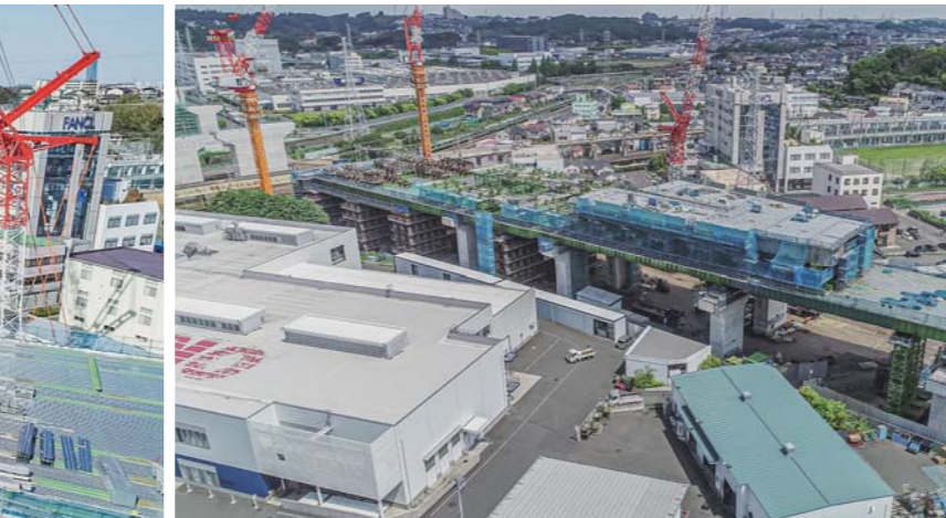
上り線桁組み立て状況
