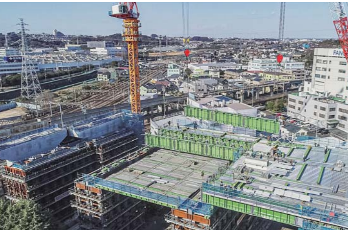
軌条桁設置状況
