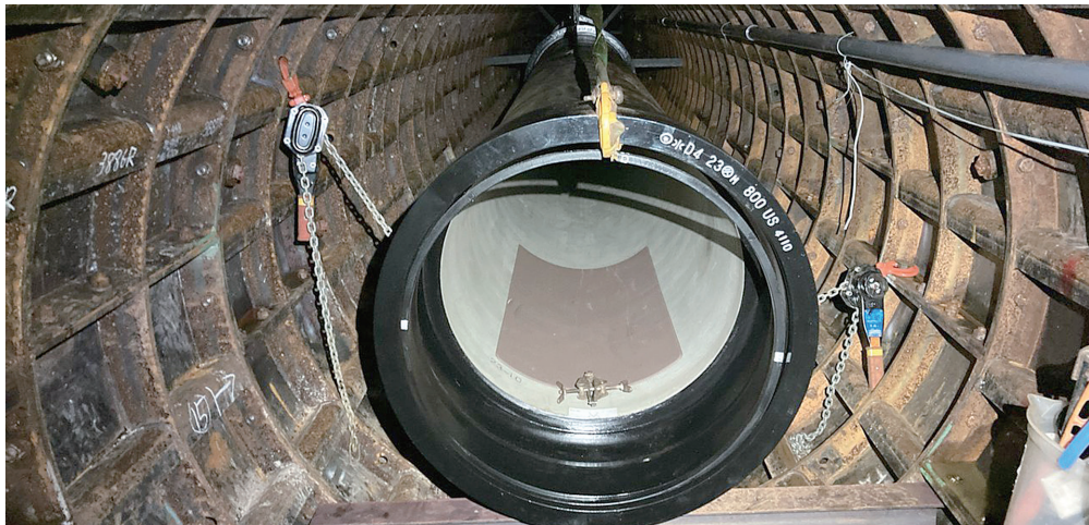
トンネル内に水道管設置
