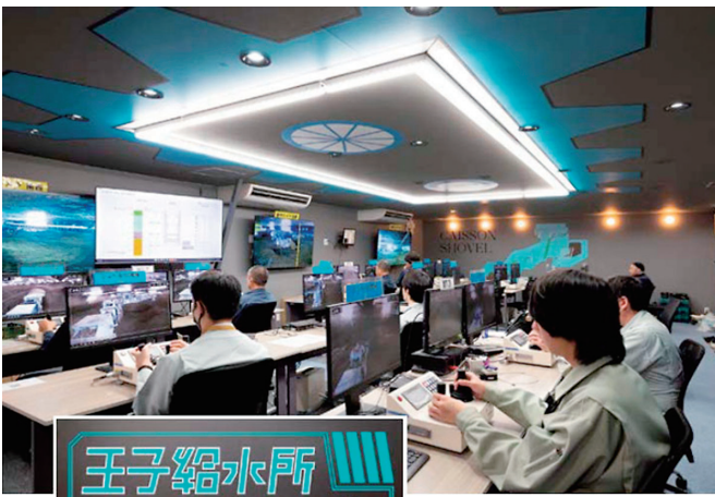
ケーソン管理室
