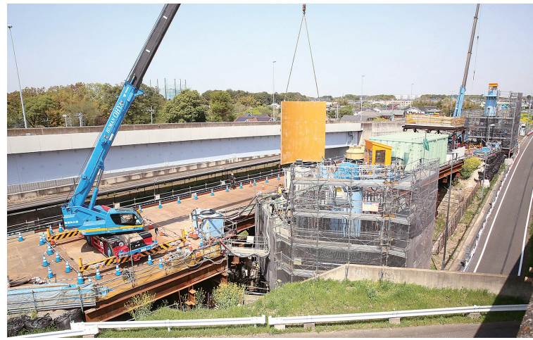
型枠設置の様子
