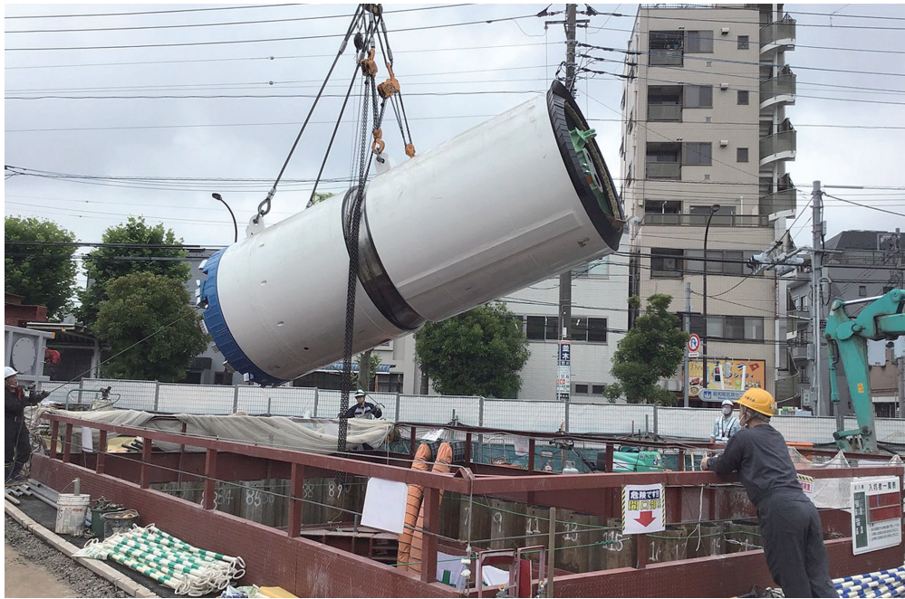
シールドマシン投入
