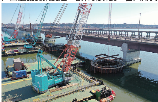
湖上での打設作業
