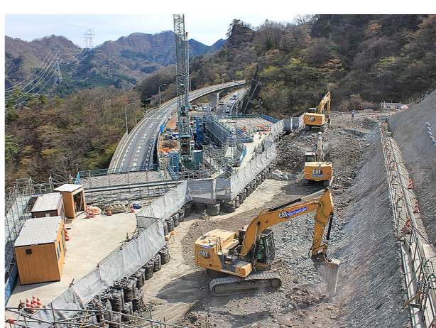
岩を砕き、バックホウでダンプに積み込む
