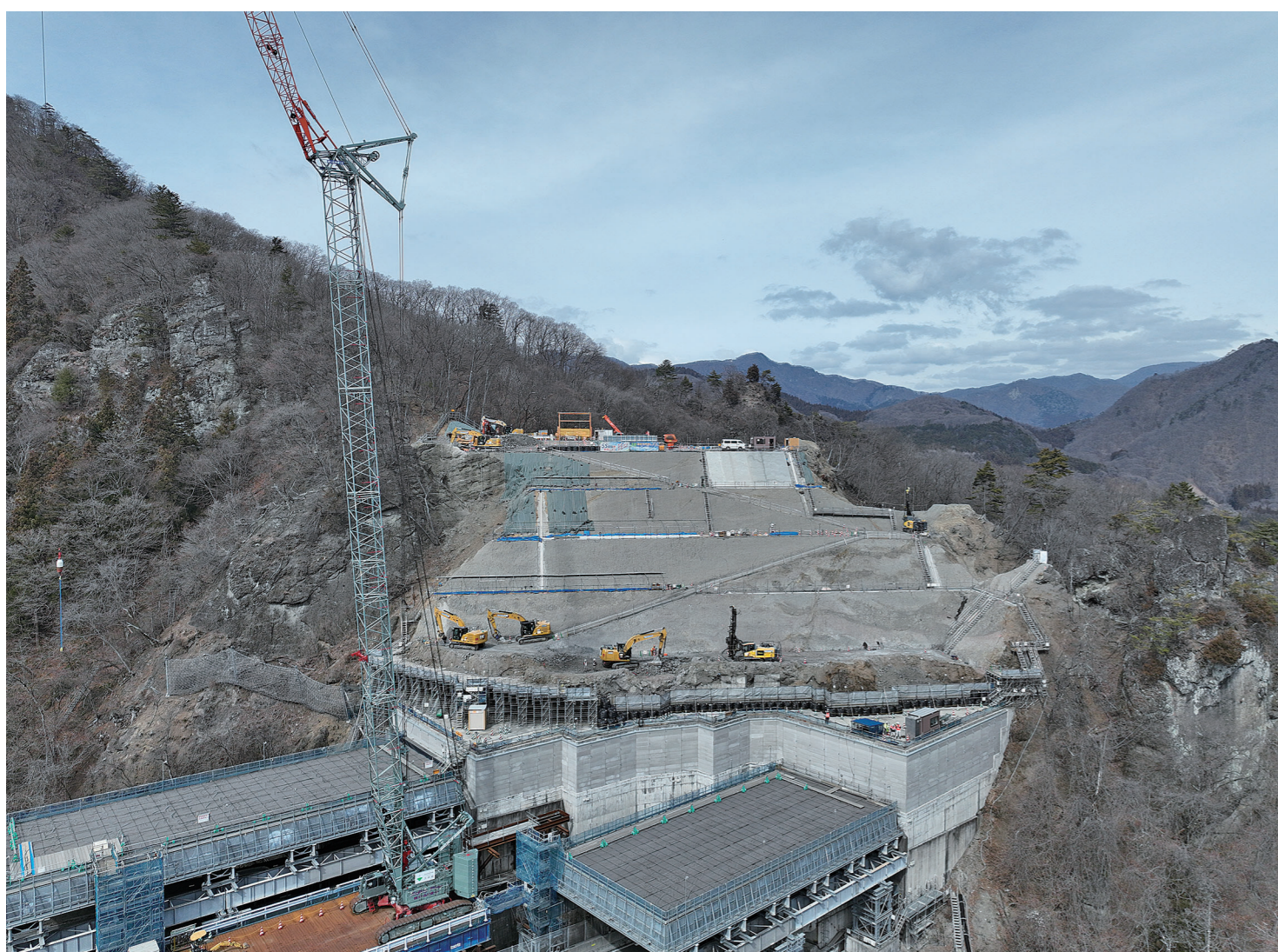
岩を割り進め、のり面にコンクリートを吹き付けて保護した(2026年3月13日撮影)
