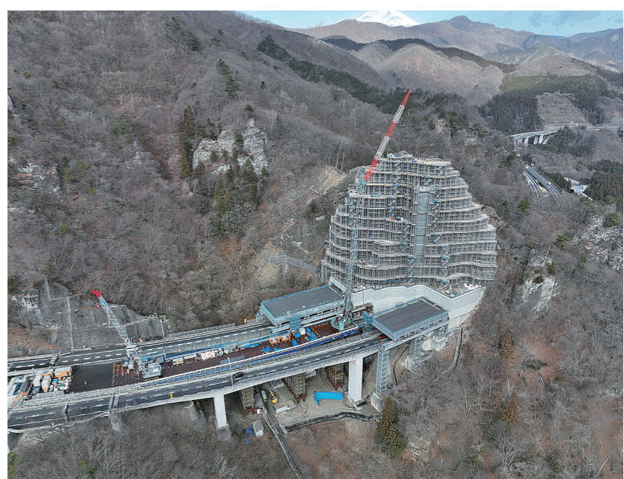
ロックボルトと高強度金網。作業現場を兼ねた防護柵で落石・飛び石を防いだ(2023年3月10日撮影)
