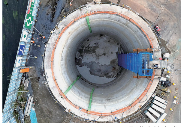
発進立坑完成
