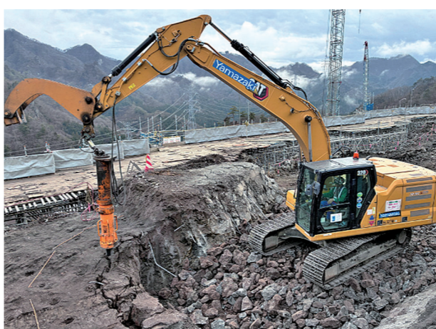
火薬類を使わずに岩石や岩盤の破砕が可能なヒッガー
