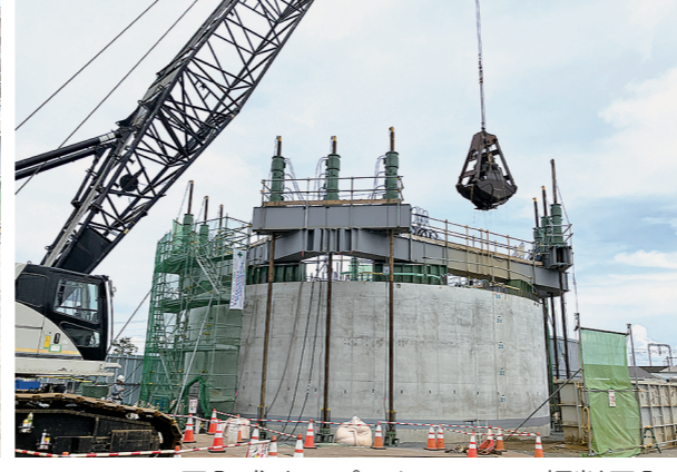
圧入式オープンケーソン 掘削圧入
