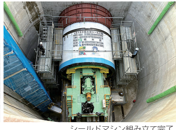
シールドマシン組み立て完了
