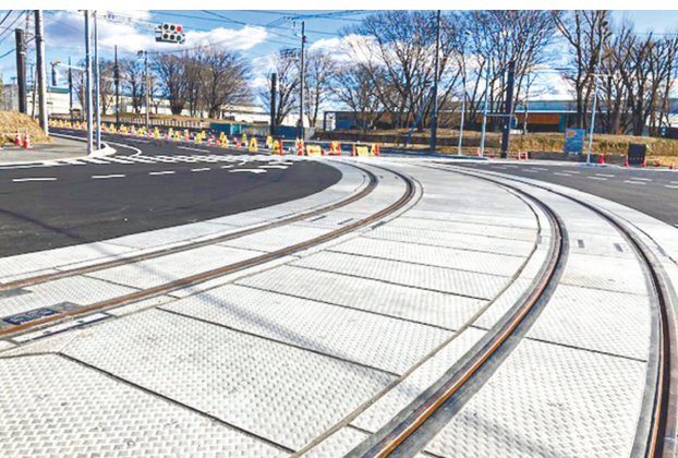
急曲線部交差点の施工後
