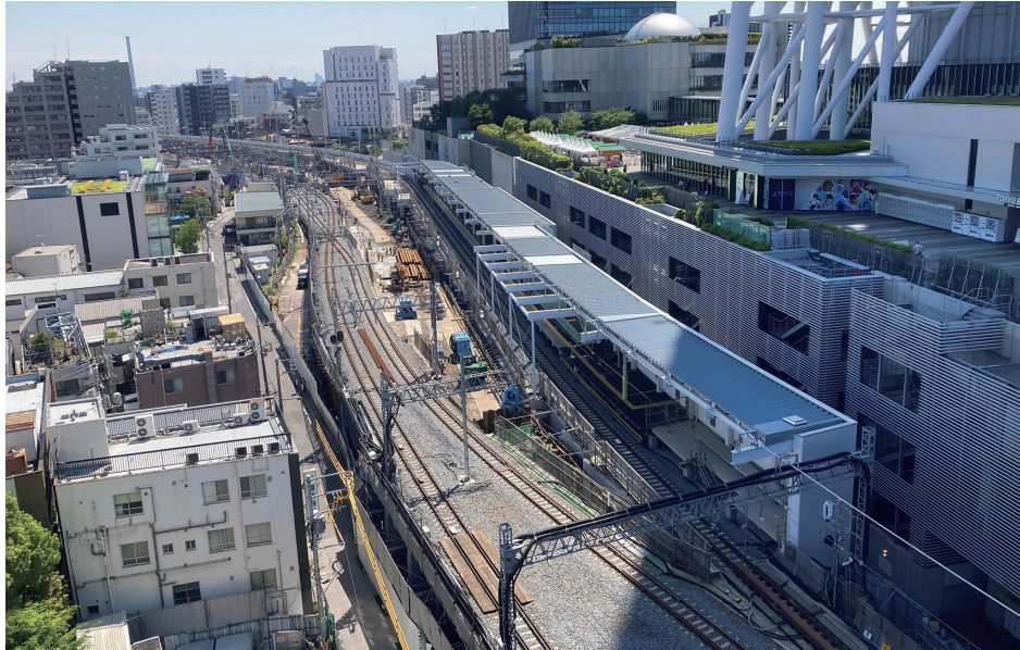
Ⅱ工区全景(浅草方)(写真提供：大林・東武谷内田JⅤ)
