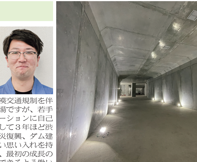
PCCボックスカルバートで構築された地下車路
