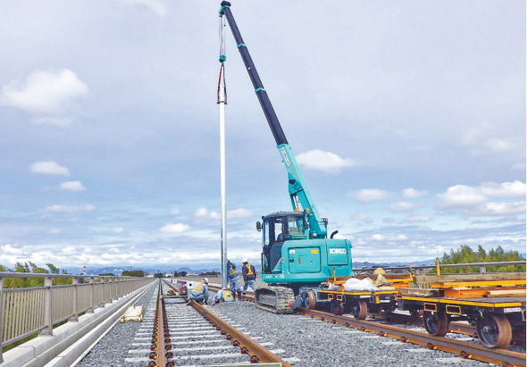
電化柱の建植作業の様子
