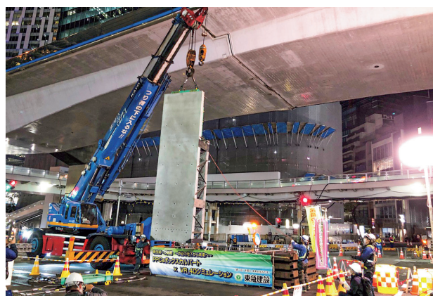
道路規制された現場での部材投入の様子
