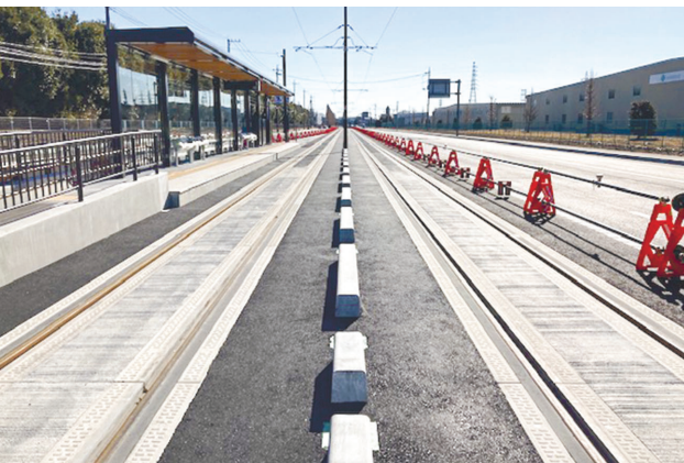
一般部停留場付近の施工後
