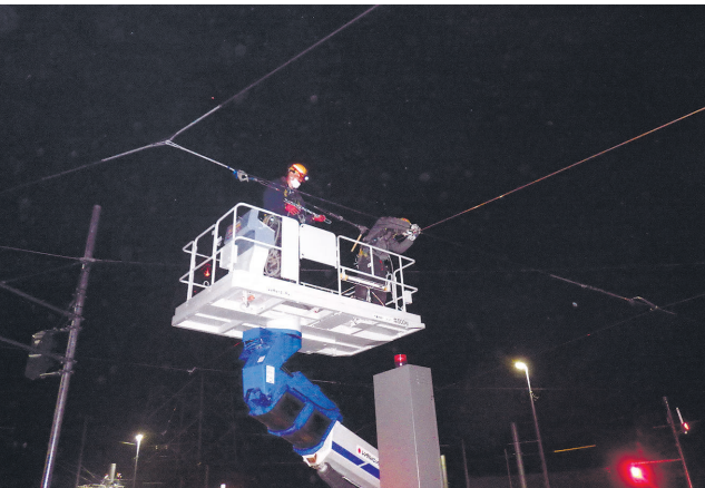
施工中の現場の様子
