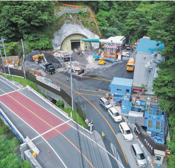
トンネル入口の作業ヤード
