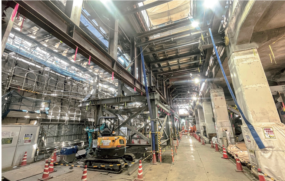
軌道仮受け方式による高架橋施工状況(写真提供：東急・河本JⅤ)
