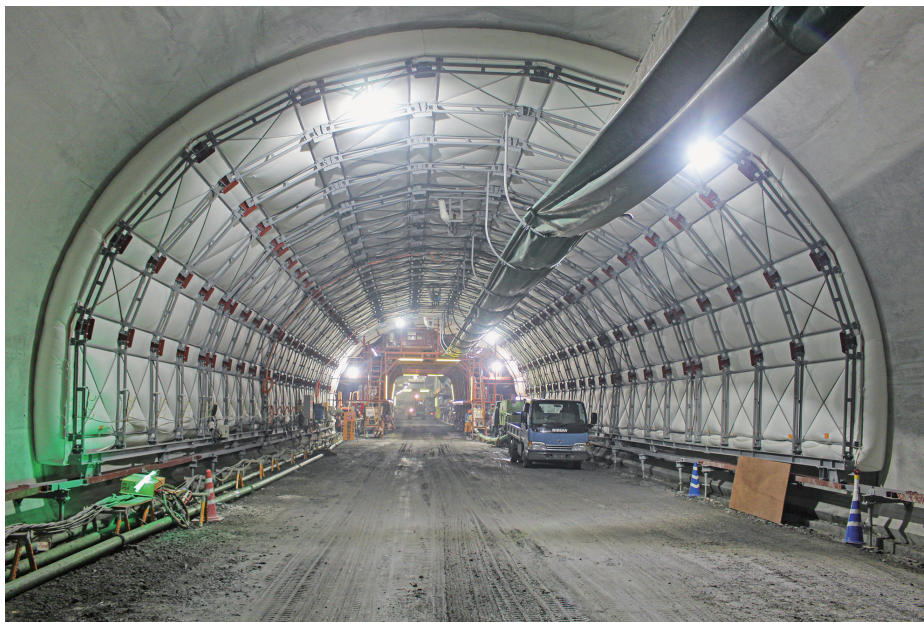
給水養生「アクアカーテン」
