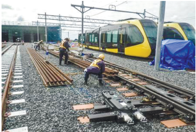
施工中の現場の様子
