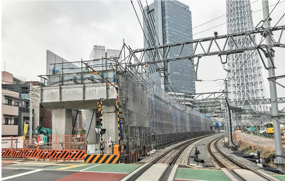
上り線高架橋の施工状況(写真提供：鹿島・東武谷内田・東鉄JⅤ)
