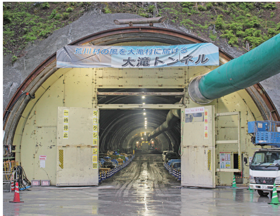
トンネル入口
