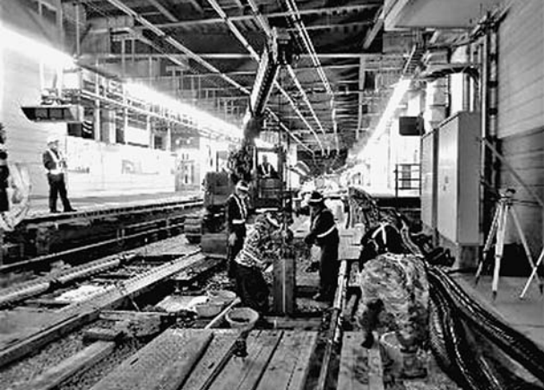
工事進捗状況
