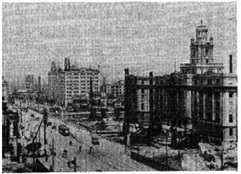
昭和5年の市役所前建設工事
