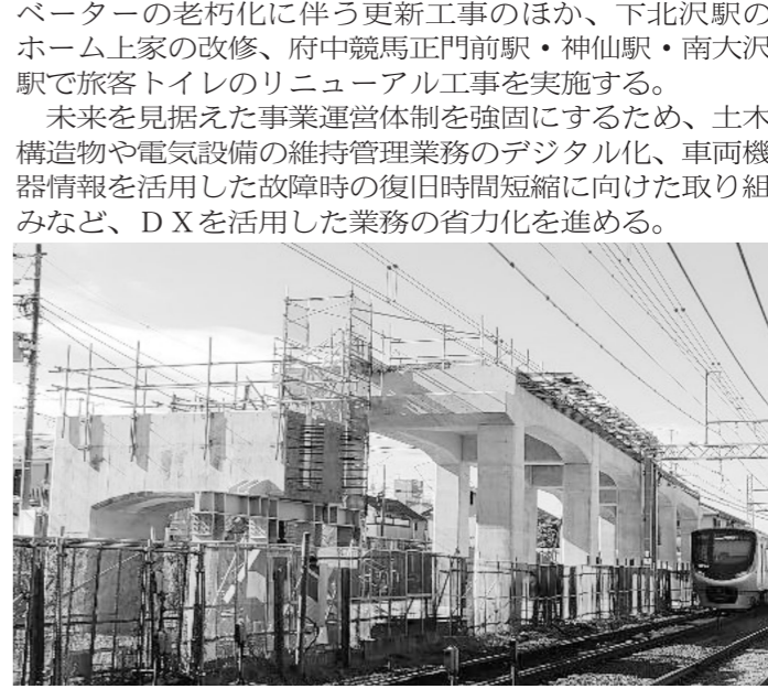
一部完成した高架橋躯体(明大前駅付近)
