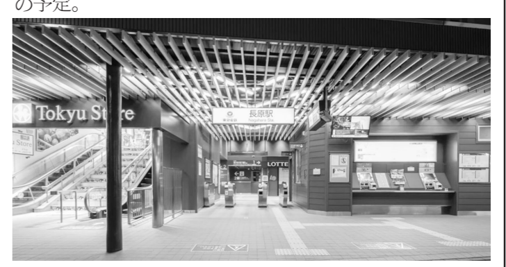
21年12月に「木になるリニューアル」が竣工した長原駅
