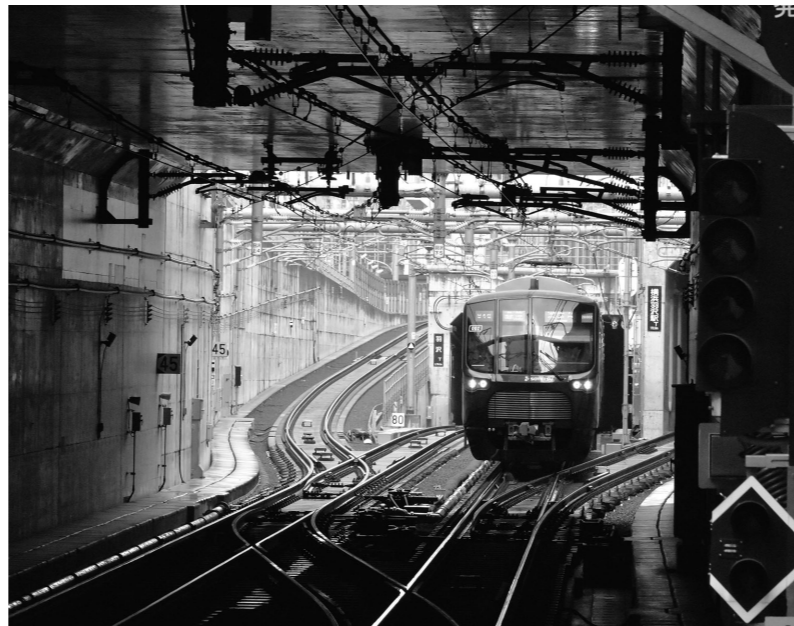
相鉄・東急新横浜線（神奈川県海老名市～東京都目黒区、渋谷区） 3月18日開業。東急線と相鉄線の相互直通運転が可能となり、速達性の向上や乗り換え回数の抑制を実現した
