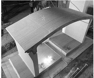
屋根も一つの部材で構成している
