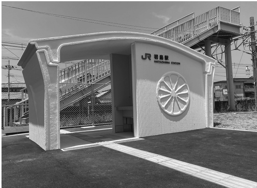
完成したJR西日本初島駅の駅舎（7月7日撮影）
