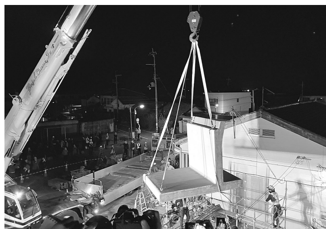
部材をクレーンでつり上げて据え付けた
