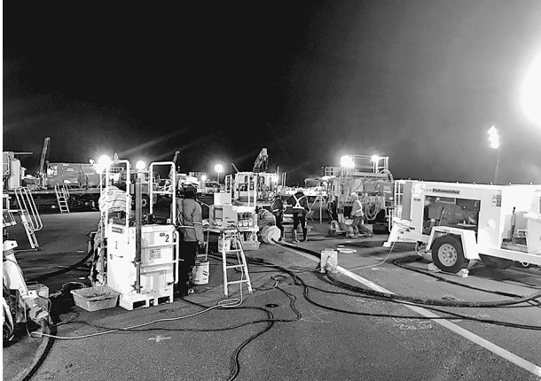
施工状況（近景）
