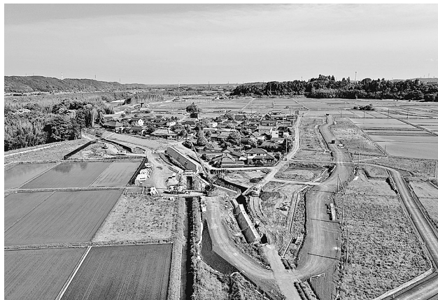
輪中堤施工状況
