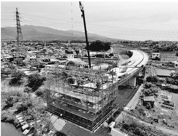
張出架設機（フーゲン）組立状況
