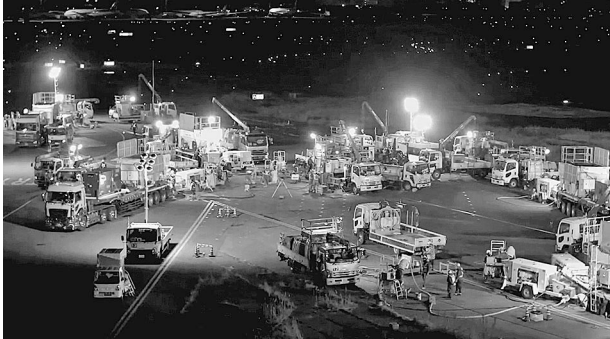
施工状況（遠景）
