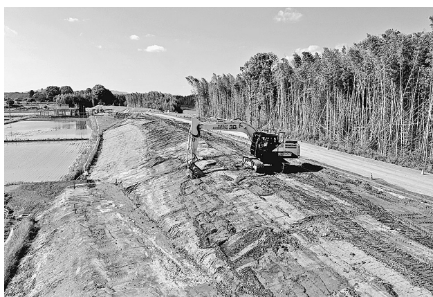
本堤施工状況
