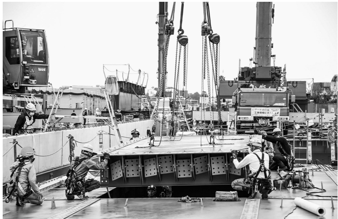
中国道リニューアル工事での鋼製床版取り換え作業(宮の前高架橋)
