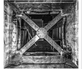
断熱材の設置状況 (実大施工実験)
