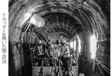
Tカッターを用いた施工状況
