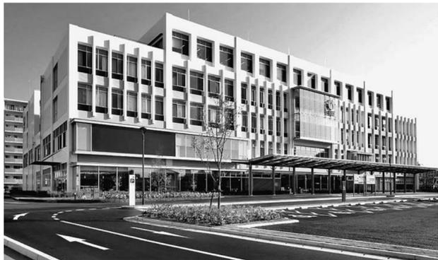
免震+PC圧着関節工法による病院建築
