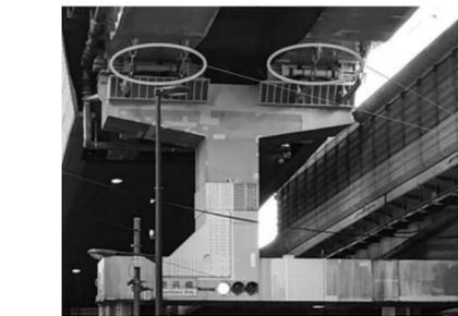
図1 DRF-DPを用いた橋梁耐震工法(首都高速道路11号台場線)
