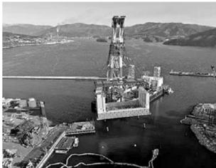
函体およびゲート据付状況
