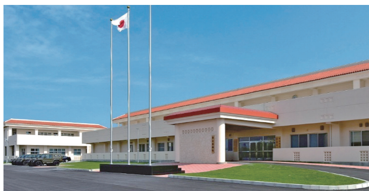
宮古島駐屯地 隊庁舎
