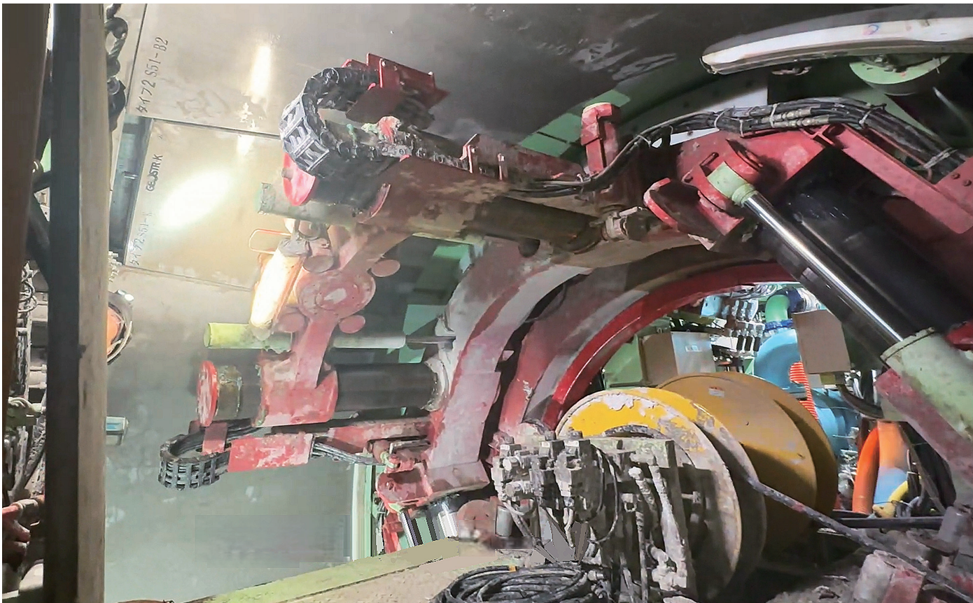
エレクターによるセグメントの組み立て
