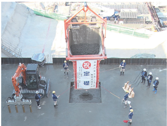
コンクリートバケットによる埋納
